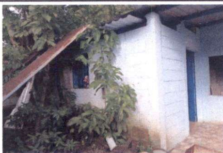
Foto 3: Reparación de pared y columna
