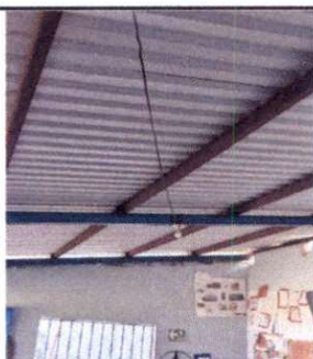
Foto 9: Cambio de estructura de metal por metal debido al deterioro por el paso de los años y reparación de cableado eléctrico, lámparas, conectores y apagadores
