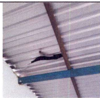
Foto 10: Cambio de láminas troqueladas calibre 26
