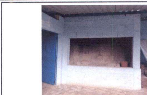
Foto1: Cambio de estufa rural completa, cernido y repello en chimenea
