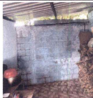
Foto 4: Cernido, repello e impermeabilización en paredes
