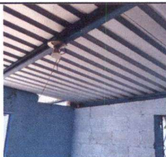
Foto 5: Cambio de cableado eléctrico y sus accesorios
