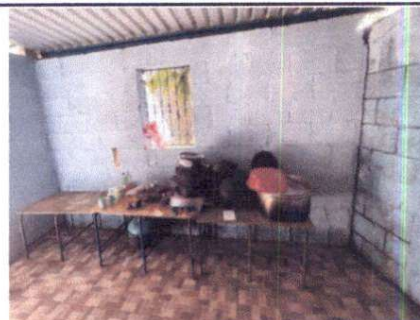
Foto 2: Cambio de ventana de metal por ventana de metal y muebles de cocina de madera a concreto y azulejo por deterioro por los años
