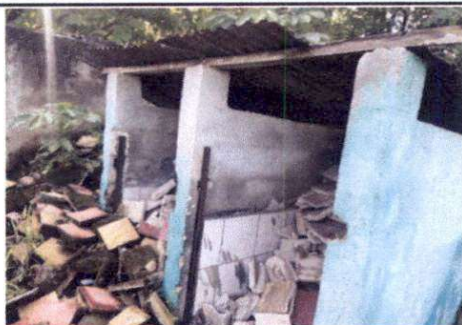
Foto 7: Cambio de azulejo, sanitarios y reparación de paredes
