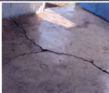
Foto 11: Cambio de piso por deterioro por el paso de los años por piso cerámico
