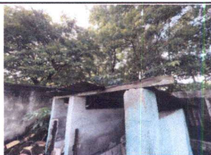
Foto 6: Cambio de estructura de madera a metal y lamina por lamina calibre 26 debido al deterioro
