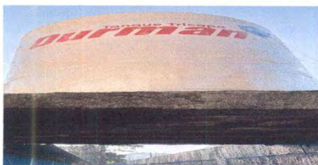
Foto 5. Sustitución de accesorios deposito de agua
