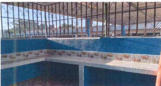
Foto 5. Suministro e instalación de azulejo en mesa de trabajo
