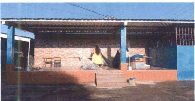
Foto 3. Suministro e instalación de azulejo
