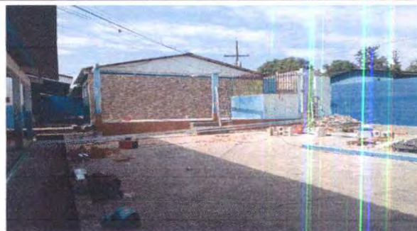
Foto 2. Sustitución de estructura y lamina
