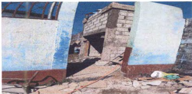
Foto 1. Suministro de puertas metálicas en cocina
