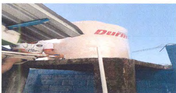
Foto 5. Sustitución de accesorios deposito de agua
