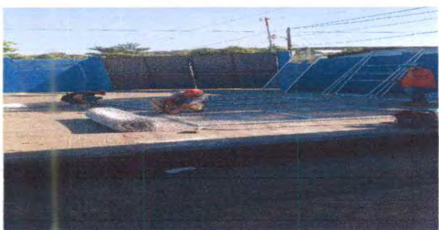
Foto 5. Reparación de muro perimetral
