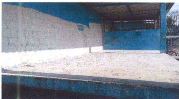
Foto 3. Suministro e instalación de azulejo
