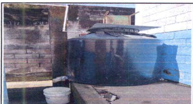
Foto 5: Sustitución de accesorios depósito de agua
