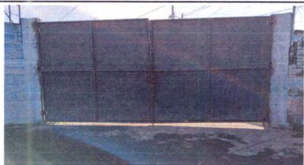
Foto 1: Sustitución de portón de metal corredizo
