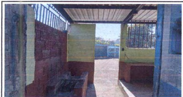
Foto 3: Sustitución de puerta para cocina
