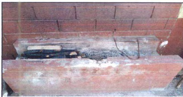
Foto 1: Sustitución de estufa rural (completa)
