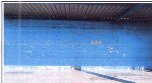
Foto 3. Suministro e instalación de azulejo
