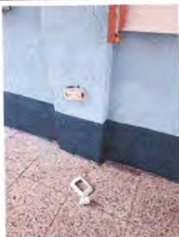
Foto 7: REPARACIÓN DEL SISTEMA ELÉCTRICO EN AULAS 1,2,3 Y CORREDOR. (Sustitución de tomacorrientes dobles)
