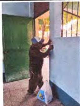
Foto 8: REPARACIÓN DEL SISTEMA ELÉCTRICO EN AULAS 1,2,3 Y CORREDOR. (Sustitución de tomacorrientes dobles)
