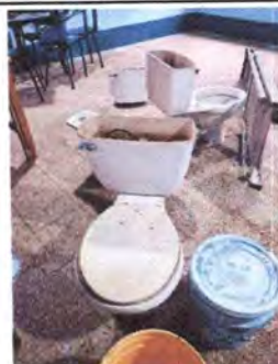
Foto 12: SERVICIOS SANITARIOS Y ACCESORIOS. (Sustitución de inodoro en el área de mujeres)
