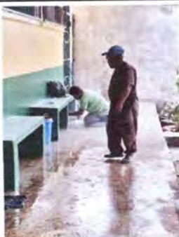
Foto 9: PISO. Mantenimiento de piso de granito en todo el Centro Educativo (pulido y lustrado)
