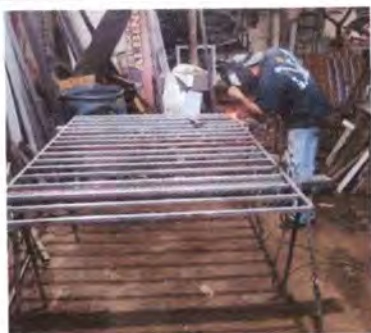
Foto 1: VENTANAS DE AULAS 1,2,3,4, BAÑOS EN HOMBRES Y MUJERES, BODEGA Y DIRECCIÓN (sustitución de balcones de metal)
