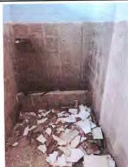
Foto 10: REPARACIÓN O SUSTITUCIÓN DE AZULEJO EN BAÑO DE VARONES
