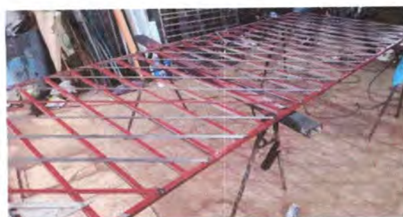
Foto 2: VENTANAS DE AULAS 1,2,3,4, BAÑOS EN HOMBRES Y MUJERES, BODEGA Y DIRECCIÓN (Sustitución de balcones de metal)
