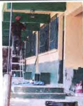
Foto 3: PINTURA DE MUROS EXTERIORES EN TODO EL CENTRO EDUCATIVO Y PINTURA DE INTERIORES DE AULAS 1,2,3,4, BAÑOS EN HOMBRES Y MUJERES, BODEGA Y DIRECCIÓN
