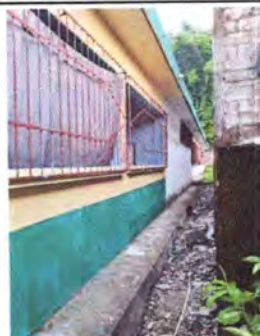
Foto 4: PINTURA DE MUROS EXTERIORES EN TODO EL CENTRO EDUCATIVO Y PINTURA DE INTERIORES DE AULAS 1,2,3,4, BAÑOS EN HOMBRES Y MUJERES, BODEGA Y DIRECCIÓN
