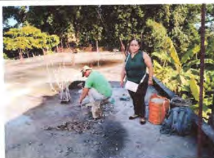
Foto 11: IMPERMEABILIZACIÓN DE LOSA DE TODO EL CENTRO EDUCATIVO. (Impermeabilización de losa)
