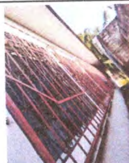
Foto 2: VENTANAS DE AULAS 1,2,3,4, BAÑOS EN HOMBRES Y MUJERES, BODEGA Y DIRECCIÓN (Sustitución de balcones de metal)
