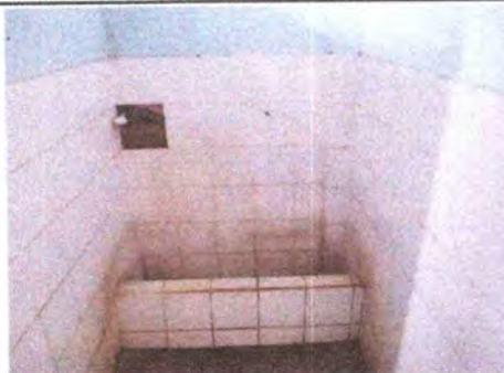
Foto 10: REPARACIÓN O SUSTITUCIÓN DE AZULEJO EN BAÑO DE VARONES
