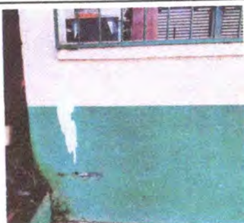
Foto 5: REPARACIÓN DE REPELO Y CERNIDO DE PAREDES EN CORREDOR, AULAS 1,2,3,4, BODEGA Y DIRECCIÓN
