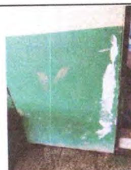
Foto 6: REPARACIÓN DE REPELO Y CERNIDO DE PAREDES EN CORREDOR, AULAS 1,2,3,4, BODEGA Y DIRECCIÓN.
