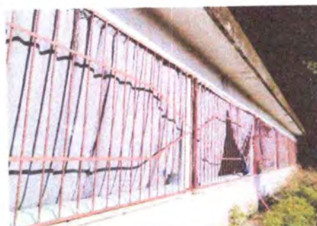
Foto 4: PINTURA DE MUROS EXTERIORES EN TODO EL CENTRO EDUCATIVO Y PINTURA DE INTERIORES DE AULAS 1,2,3,4, BAÑOS EN HOMBRES Y MUJERES, BODEGA Y DIRECCIÓN.
