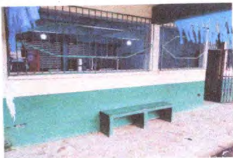
Foto1: VENTANAS DE AULAS 1,2,3,4, BAÑOS EN HOMBRES Y MUJERES, BODEGA Y DIRECCIÓN (sustitución de balcones de metal)
