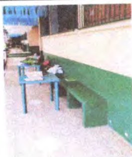
Foto 3: PINTURA DE MUROS EXTERIORES EN TODO EL CENTRO EDUCATIVO Y PINTURA DE INTERIORES DE AULAS 1,2,3,4, BAÑOS EN HOMBRES Y MUJERES, BODEGA Y DIRECCIÓN
