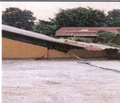
FOTO 15: Módulo 1 Reparación de cableado eléctrico en Dirección.
