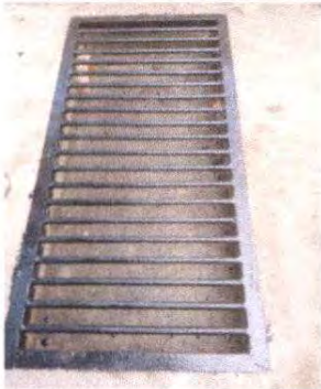
FOTO 9: Modulo 3 Patio sustitución de tubería PVC línea principal de aguas pluviales
