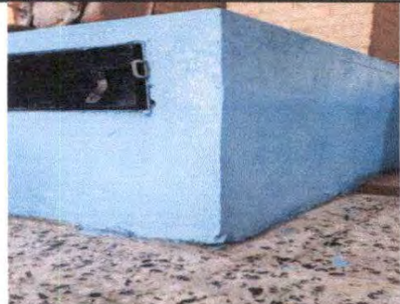
FOTO 12: Modulo 3 Reparación de cocina
