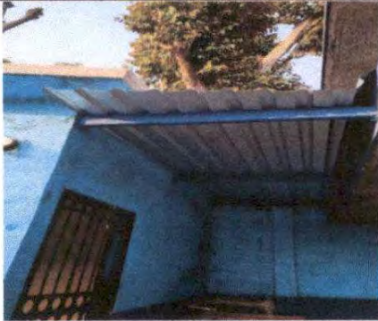
FOTO 1: Módulo 1 Cambio cubierta de láminas en Dirección
