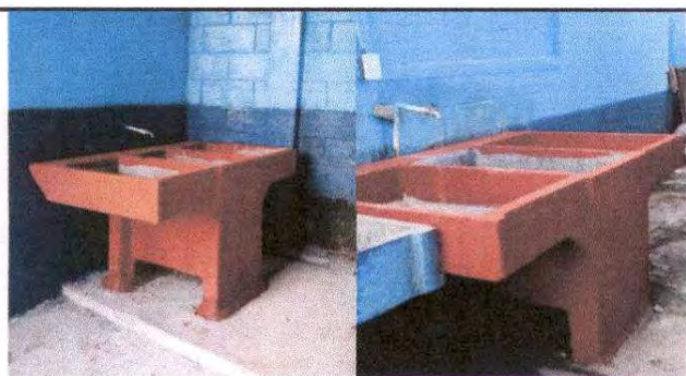
FOTO 17: Módulo 3 Instalación de pila cerca de los baños.
