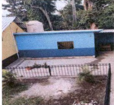
FOTO 10: Módulo 1 Patio reparación de planchas de concreto de patio
