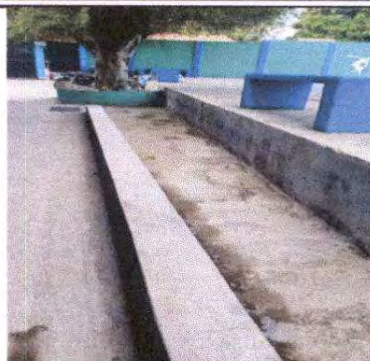
FOTO 14: Repello y cernido de patio frente a Módulo 3
