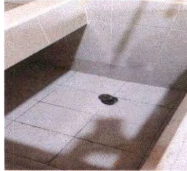
FOTO 8: Módulo 3 COCINA: Sustrución de azulejo en pila
