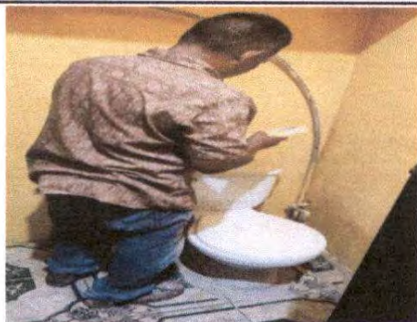
FOTO 7: Modulo 1 BAÑO DE DIRECCION: Sustitución de llave de paso
