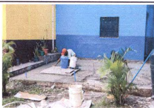
FOTO 10: Módulo 1 Patio reparación de planchas de concreto de patio
