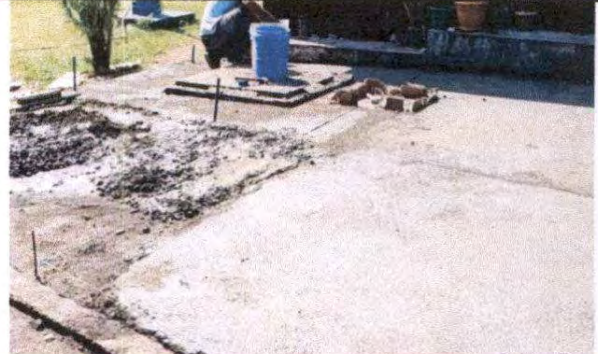
FOTO 16: Módulo 1 Reparacion de plancha de concreto en patio
