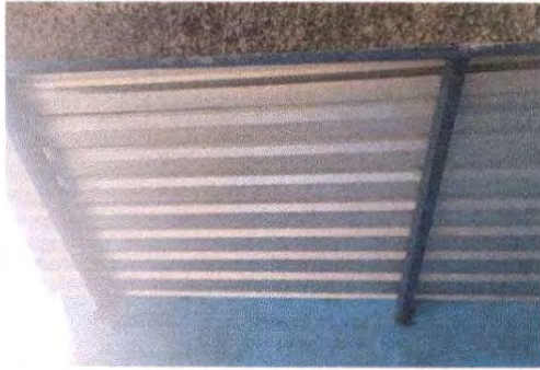
FOTO 1: Módulo 1 Cambio cubierta de láminas en Dirección
