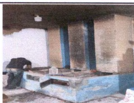
FOTO 12: Modulo 3 Reparación de cocina
