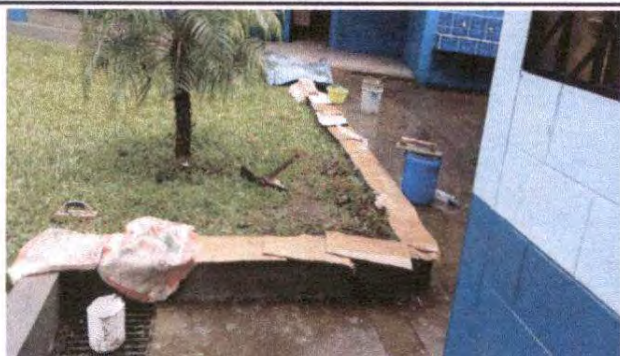
FOTO 9: Módulo 3 Patio sustitución de tubería PVC línea principal de aguas pluviales
