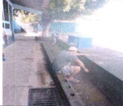
FOTO 14: Repello y cernido de patio frente a Módulo 3
