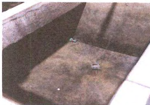
FOTO 8: Módulo 3 COCINA: Sustitución de azulejo en pila
