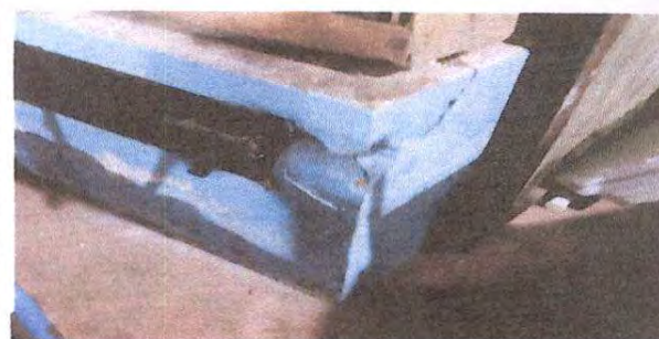
FOTO 12: Módulo 3 Reparación de cocina
