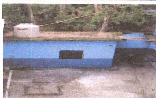
FOTO 10: Módulo 1 Patio reparación de planchas de concreto de patio
