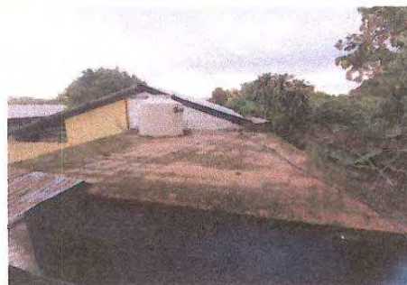
FOTO 2: Módulo 1 Impermeabilización de losa en Dirección
