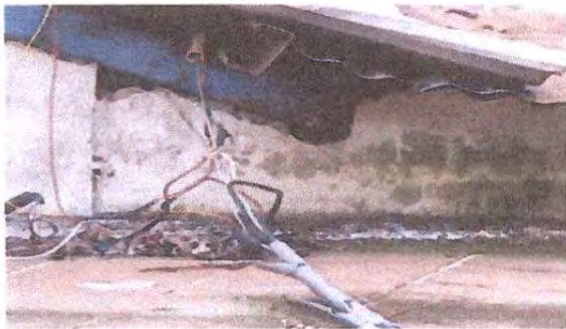
FOTO 15: Módulo 1 Reparación de cableado eléctrico en Dirección.
