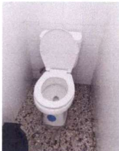
Foto 1: SUSTITUCIÓN DE SANITARIOS
