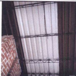
Foto 1: CUBIERTA DE LAMINA Y ESTRUCTURA DE TECHO AREA DE COCINA
