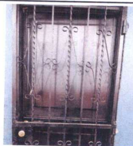
Foto 6: SUSTITUCIÓN DE PUERTA DE COCINA
