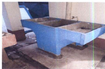
Foto 6: SUSTITUCIÓN DE PILA EN CORREDOR
