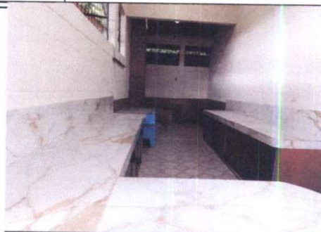
Foto 2: REPARACIÓN DE COCINA EN PISO, PILA, VENTANAS Y MUEBLES DE COCINA
