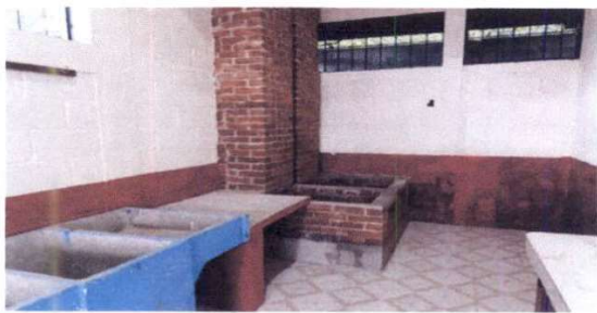
Foto 3: SUSTITUCION DE PISO EN COCINA
