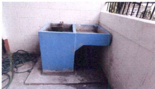
Foto 5: SUSTITUCIÓN DE PILAS EN CORREDOR
