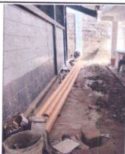
Foto 3: CANALES Y BAJAS DE AGUA PLUVIAL A LA PAR DEL AULA DE 1RO B
