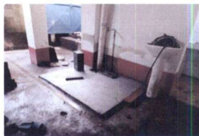
Foto 6: SUSTITUCIÓN DE PILA EN CORREDOR
