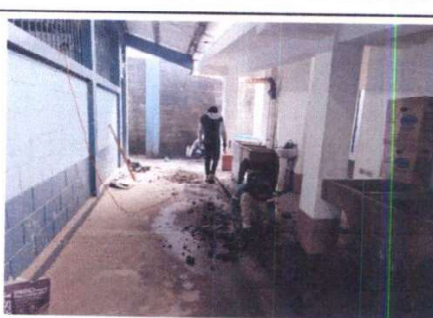
Foto 4: REPARACIÓN DE CUNETA DE CONCRETO AREA DE CORREDOR
