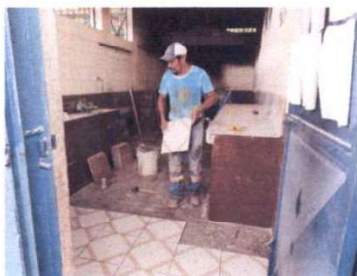
Foto 3: SUSTITUCIÓN DE PISO EN COCINA
