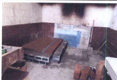
Foto 2: REPARACIÓN DE COCINA EN PISO, PILA, VENTANAS Y MUEBLES DE COCINA
