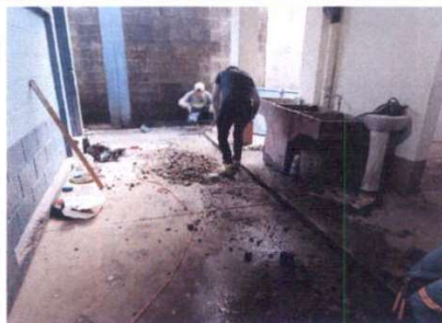
Foto 5: SUSTITUCIÓN DE PILAS EN CORREDOR
