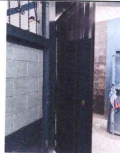
Foto 6: SUSTITUCIÓN DE PUERTA DE COCINA
