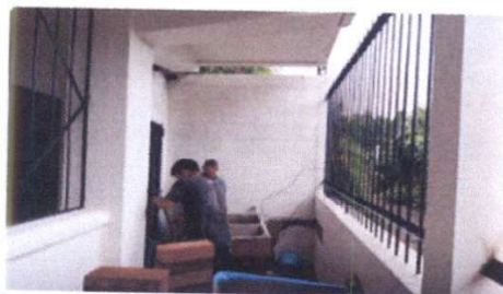
Foto 5: SUSTITUCIÓN DE PUERTAS DE METAL EN AULA DE 1RO B
