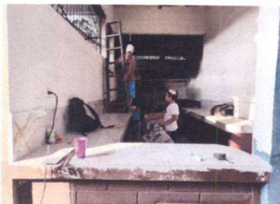
Foto 1: CUBIERTA DE LAMINA Y ESTRUCTURA DE TECHO AREA DE COCINA
