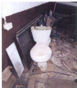
Foto 1: SUSTITUCIÓN DE SANITARIOS
