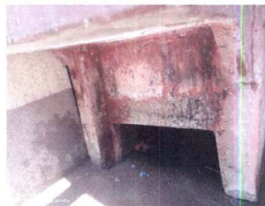
Foto 6: SUSTITUCIÓN DE PILA EN CORREDOR
