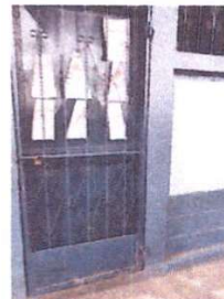
Foto 6: SUSTITUCIÓN DE PEURTA DE COCINA
