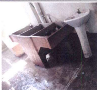
Foto 5: SUSTITUCIÓN DE PILAS EN CORREDOR
