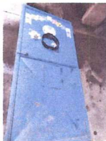
Foto 5: SUSTITUCIÓN DE PUERTAS DE METAL EN EL AULA DE 1RO B
