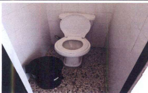
Foto 3: SUSTITUCIÓN DE SANITARIOS
