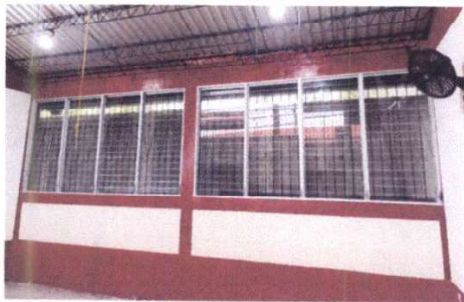
Foto1: PINTURA INTERIOR AULA PREPRIMARIA
