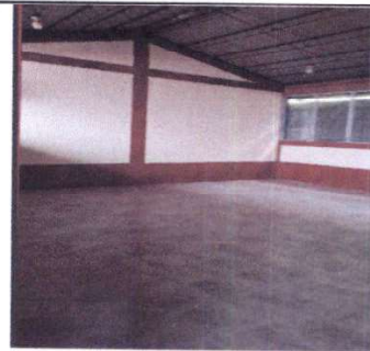
Foto 4: SUSTITUCIÓN DE PISO EN PREPRIMARIA
