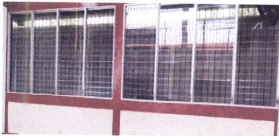
Foto 5: SUSTITUCIÓN DE VENTANAS DE METAL POR VIDRIO PVC BLANCO
