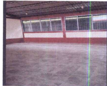
Foto 2: SUSTITUCION DE PISO DE CEMENTO POR PISO CERAMICO
