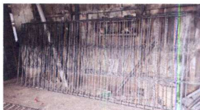
Foto 6: MANTENIMIENTO DE BALCONES
