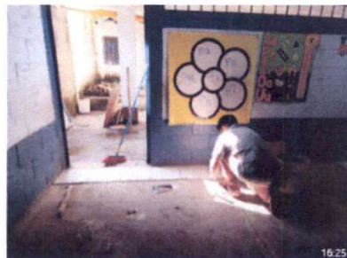
Foto 4: SUSTITUCIÓN DE PISO EN PREPRIMARIA
