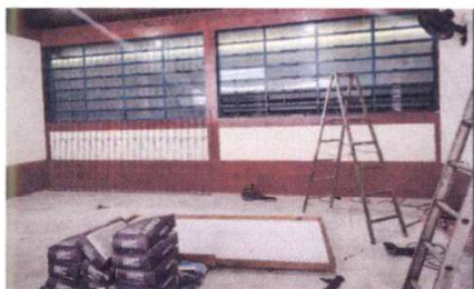
Foto 5: SUSTITUCIÓN DE VENTANAS DE METAL POR VIDRIO PVC BLANCO
