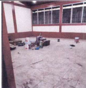
Foto1: PINTURA INTERIOR AULA PREPRIMARIA
