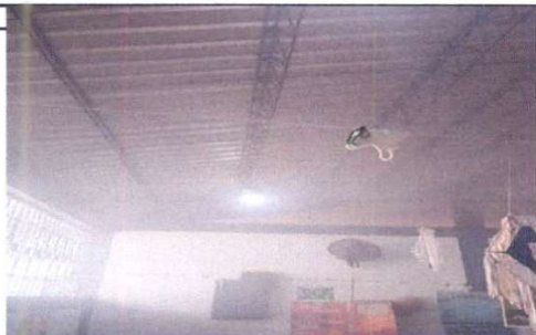
Foto 3: PINTURA INTERIOR DE AULAS
