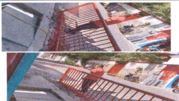
Foto1: Pintura de baranda (lijado, cepillado, pintura anticorrosiva)
