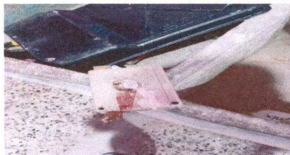
Foto 6: Sustitución de chapa
