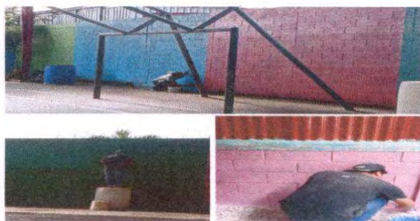
Foto 5: Pintura en muros interiores y exteriores
