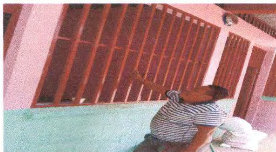
Foto 5: Suministro de balcon de metal para cocina tubo cuadrado 1" X 1"
