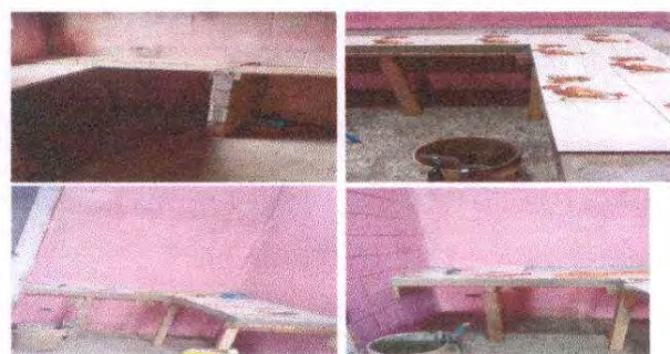
Foto 3: Suministro de desayunoador 2.50M largo 1.60 M ancho Revestido de Azulejo
