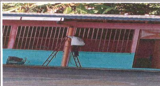
Foto 4: Mantenimiento a balcones de metal (Lijado Cepillado, pintura anticorrosiva.)
