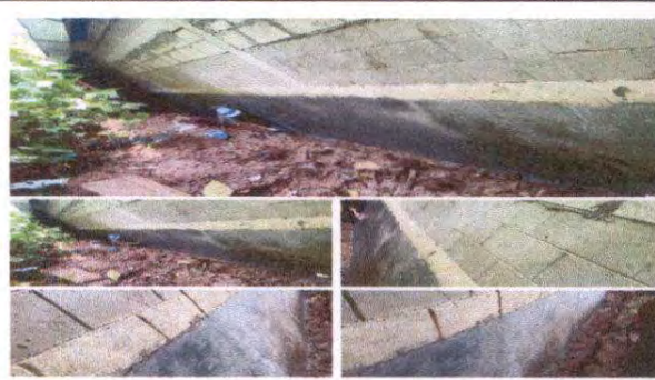
Foto 2: Repello y cerrnido de Pared
