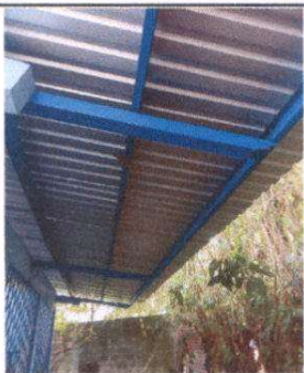
Foto 1: Suministro de lámina por lámina troquelada Aluzinc calibre 26
