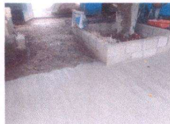
Foto 2: Reparación de planchas de concreto de patio
