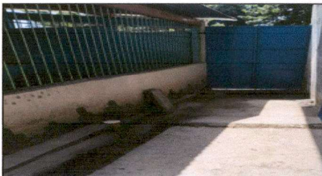
Foto 4: Sustitución de portón largo 2.5 x 2 de ancho
