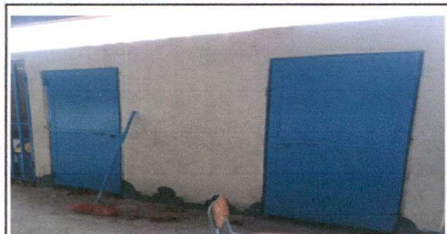
Foto 5: Sustitución de puerta en servicio sanitarios
