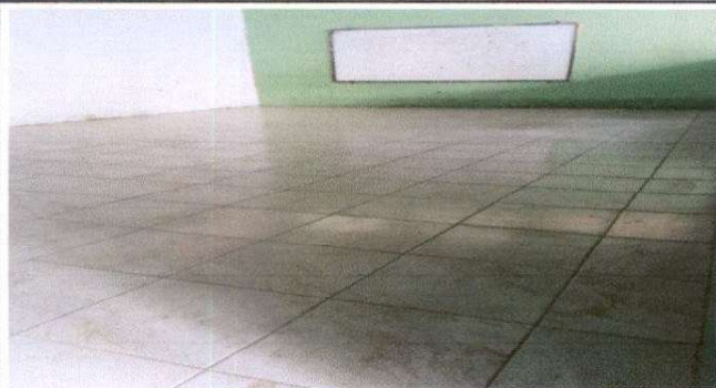
Foto 1: Sustitución de piso de granito por ceramico
