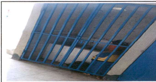
Foto 6: Sustitución de puerta de rejas largo 2 x 1.30 ancho
