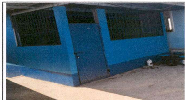
Foto 3: Sustitución de balcón de hierro en ventana largo 2.5 x 1.5
