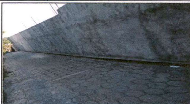
Foto 2: Reparación de muro perimetral
