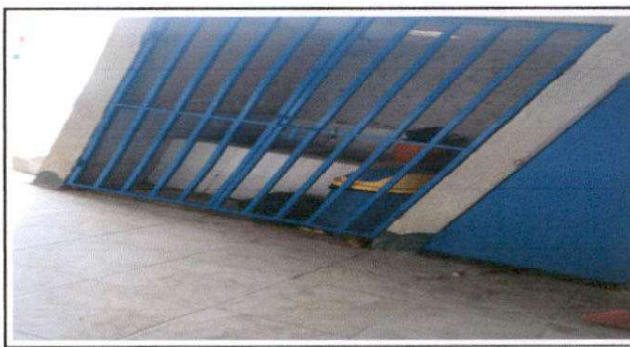
Foto 6: Sustitución de puerta de rejas largo 2 x 1.30 ancho
