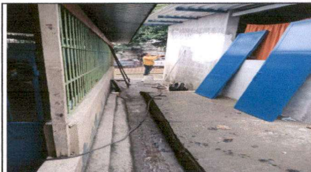
Foto 4: Sustitución de portón largo 2.5 x 2 de ancho
