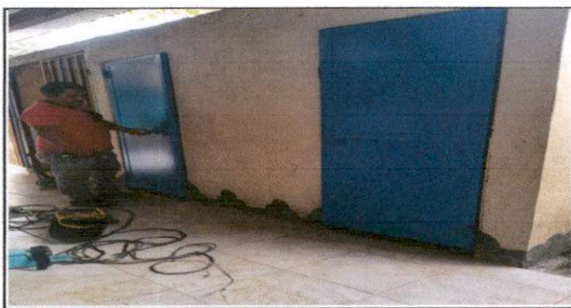
Foto 5: Sustitución de puerta en servicio sanitarios
