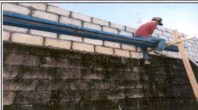
Foto 2: Reparación de muro perimetral
