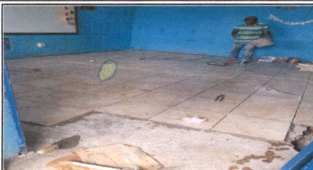
Foto1: Sustitución de piso de granito por ceramico
