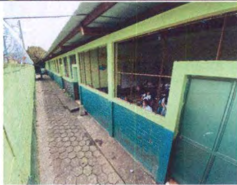
Foto 1: Lijado, cepillado, sujeciones y aplicación de pintura en puertas de aulas, baño y cocina.
