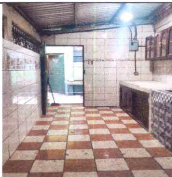
Foto 5: Suministro de azulejos en pared lateral, sustitución de filtro de agua, sustitución de pila de concreto de un lavadero, reparación de puerta de madera de gabinete.
