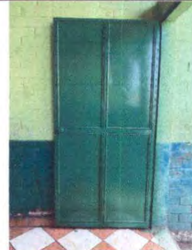
Foto 2: Lijado, cepillado, sujeciones y aplicación de pintura en puertas de aulas, baño y cocina.
