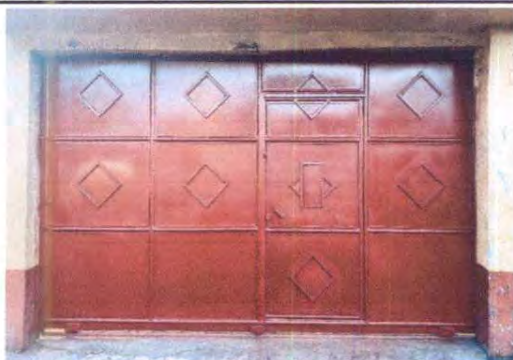
Foto 3: Mantenimiento a portón de metal principal.
