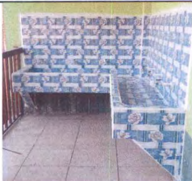
Foto 13: Suministro de lavamanos en el módulo 2 de concreto revestido de azulejo con 6 chorros, incluye tubería y accesorios.
