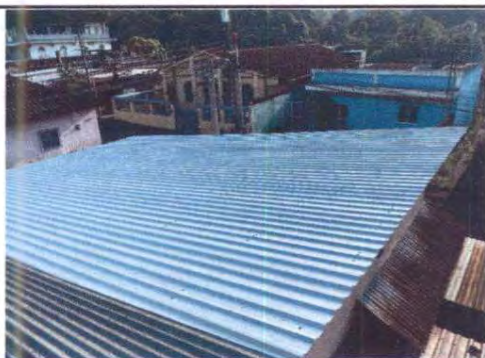
Foto 11: Sustitución de lámina por lámina en aula.
