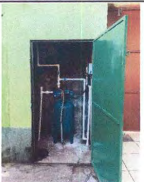
Foto 9: Sustitución de bomba hidroneumática de 1 HP vertical (incluye accesorios y sustitución de instalación eléctrica)
