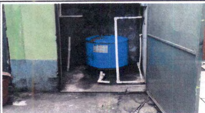
Foto 9: Sustitución de bomba hidroneumática de 1 HP vertical (incluye accesorios y sustitución de instalación eléctrica)
