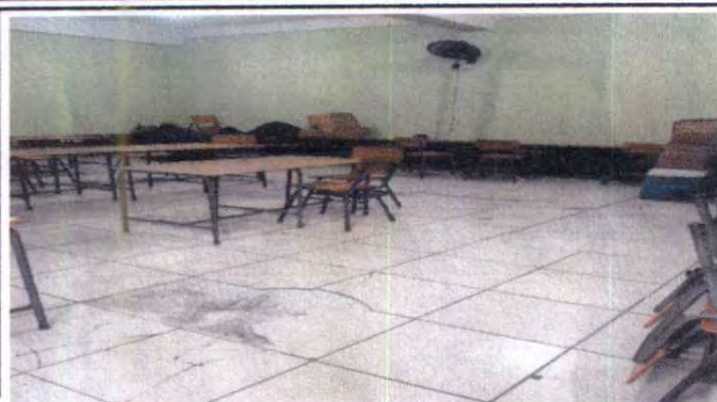
Foto 7: Sustitución de piso cerámico en mal estado por piso cerámico en laboratorio de computación.
