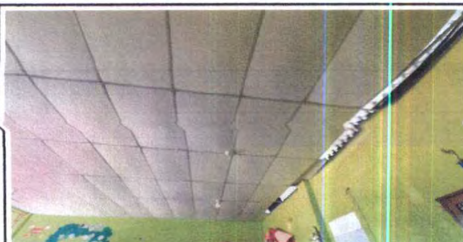
Foto 12: Reparación de cielo falso en aulas del segundo nivel (solo en áreas dañadas por ingreso de humedad)
