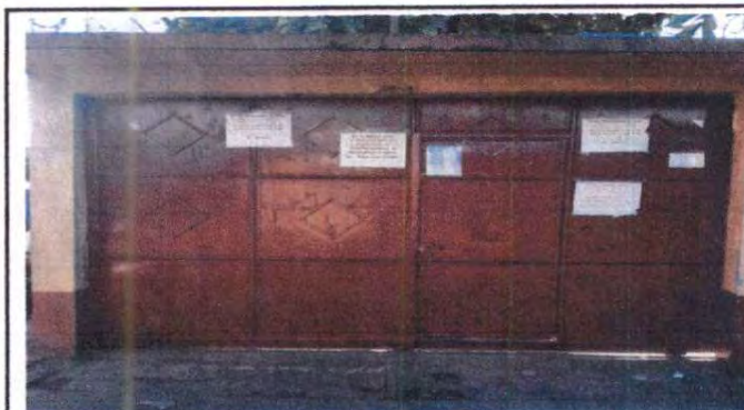
Foto 3: Mantenimiento a portón de metal principal.
