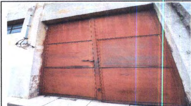
Foto 4: Mantenimiento a portón de metal emergencia.
