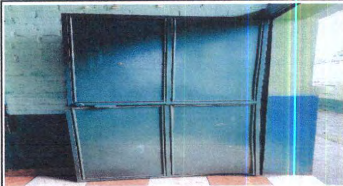
Foto 2: Lijado, cepillado, sujeciones y aplicación de pintura en puertas de aulas, baño y cocina.
