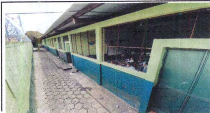
Foto 1: Lijado, cepillado, sujeciones y aplicación de pintura en puertas de aulas, baño y cocina.
