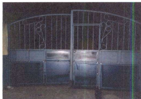
Foto 4: Reparación de portón
