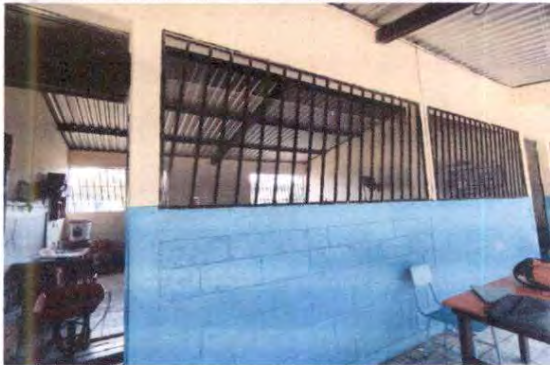
Foto1: INSTALACIÓ'N DE MALLA EN BALCONES
