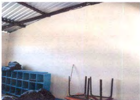
Foto 3: REPELLO Y CERNIDO EN PARED DE DIVICIÓN COCINA Y DIRECCIÓN
