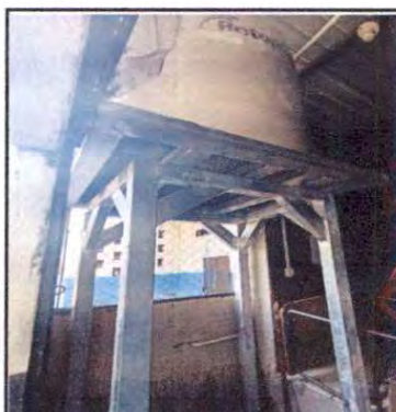
Foto 4: SUMINISTRO DE TORRE DE METAL
