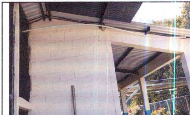
Foto 2: INSTALACION DE TUBERIA DE AGUA POTABLE
