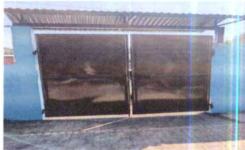
Foto 4: REPARACIÓN DE PORTON ESTRUCTURA METALICA
