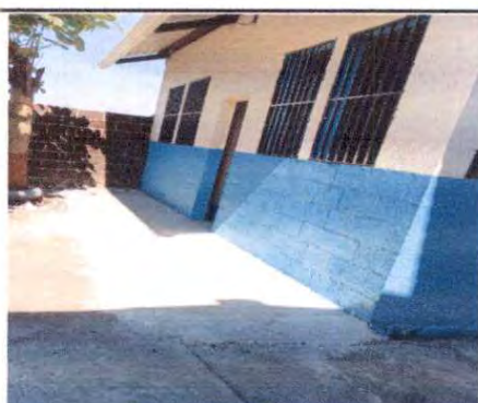
Foto 5: SUMINISTRO DE BANQUETA DE CONCRETO
