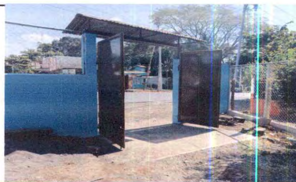
Foto 6: FUNDICIÓN DE TORTA DE CEMENTO PARA NIVELACION DE ENTRADA
