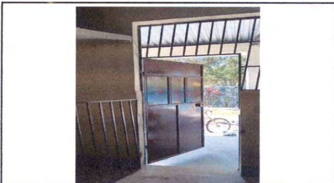
Foto 3: SUMINISTRO DE PUERTA DE METAL
