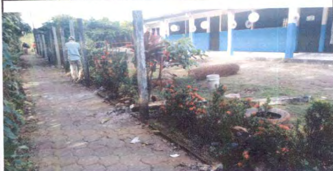
Foto 1: Sustrucción de malla en area perimetral de establecimiento
