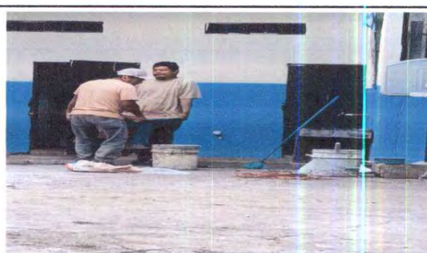
Foto 4: sustitucion de pila
