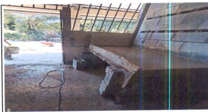
Foto 6: Realización de cocina gabinete
