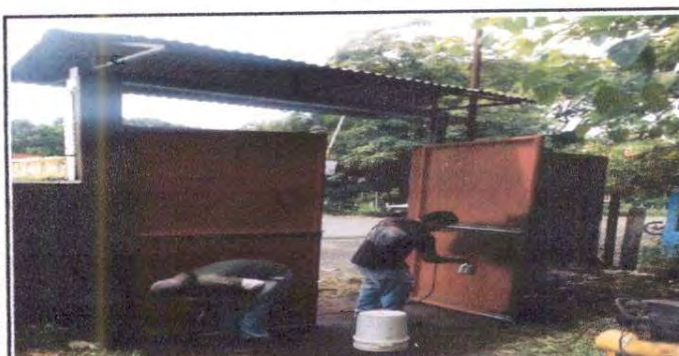
Foto 5: Sustrucción de porton de entrada de establecimiento
