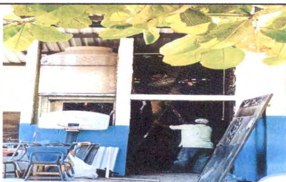
Foto 3: colocacio'n de rotoplas para sanitarios
