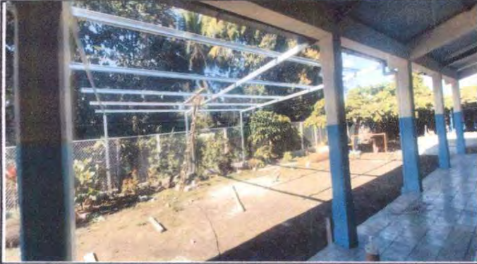
Foto1: elaboración de estructura de metal y laminado
