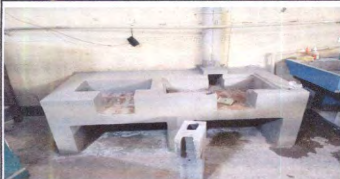
Foto 1: sustitución de cocina
