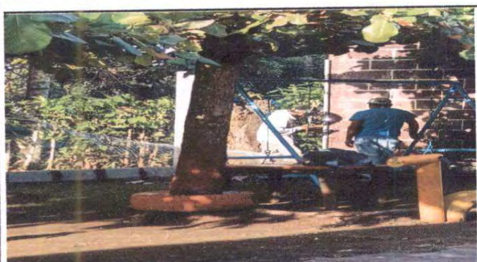
Foto 3: sustitución de malla area perimetral
