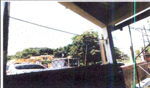
Foto 2: sustitucion de canal de agua
