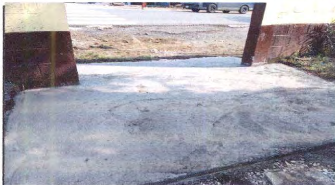
Foto 3: fundicion de torta de cemento para nivelacion de entrada
