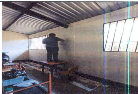
Foto 4: aplicación de pintura muros interior y exterior
