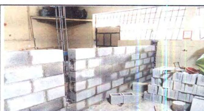
Foto 6: suministro de pared de Block para dividir dirección y cocina
