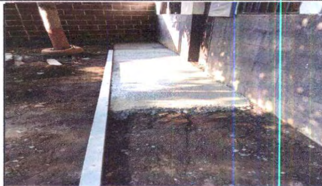
Foto 2: sustitución de banqueta de concreto
