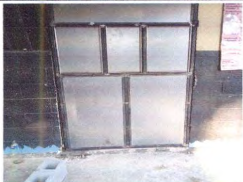
Foto1: suministro de puerta de metal para cocina
