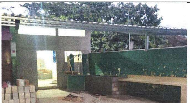
Foto 6: Mantenimiento a estructura de techo, cubierta de lamina, elevacion de pared e instalación de pila en area de cocina
