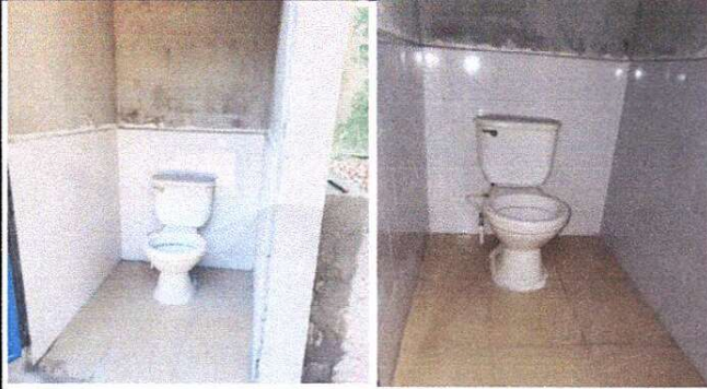
Foto1: Mantenimiento de area de baños
