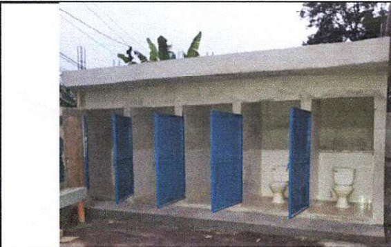
Foto 3: Elaboración de baños
