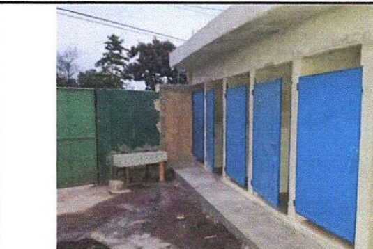
Foto 4: Mejoramiento en area de baños
