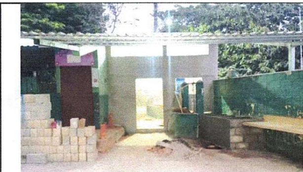
Foto 5: Mantenimiento a estructura de techo, cubierta de lamina, elevacion de pared e instalación de pila en area de cocina
