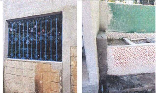
Foto 2: Mejoramiento de area de cocina, ventana y pila
