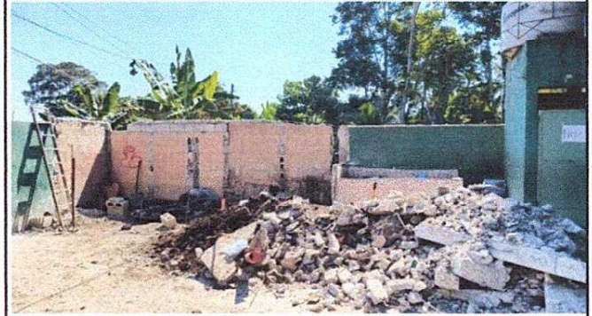
Foto 2: Area de baños
