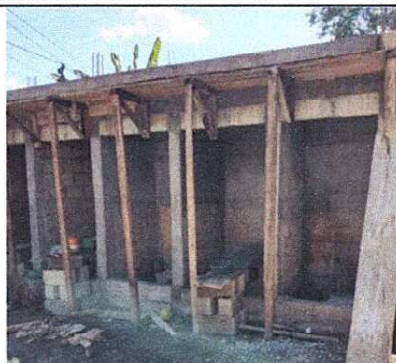
Foto 2: Mantenimiento en baños
