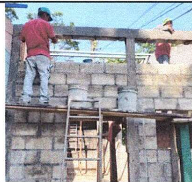
Foto 4: Elevación de pared de cocina
