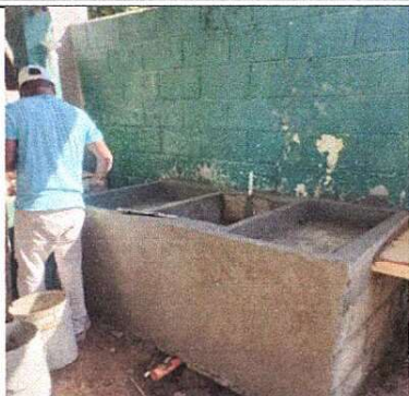
Foto 1: Suministración e instalación de pila en area de cocina
