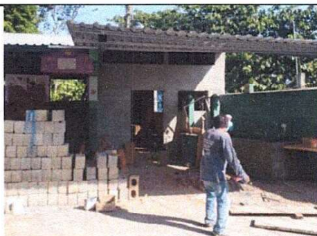
Foto 5: Mantenimiento área de cocina
