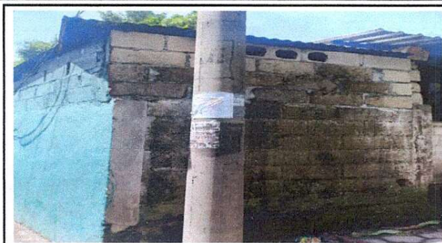
Foto 1: Área para suministro de ventana
