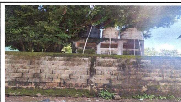
Foto 4: Suministro de malla galvanizada en muro perimetral
