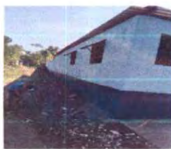
Foto 5: Pinturas en muros exteriores.
