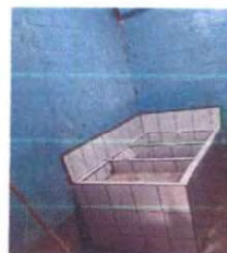
Foto 2: Sustitución de pila artesanal e instalación de azulejo.
