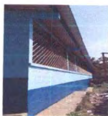
Foto 5: Pintura en muros exteriores.
