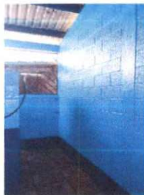
Foto 2: Sustrucción de piso por piso antideslizante.
