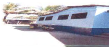
Foto 4: Pintura en muros exteriores.
