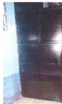
Foto 2: Mantenimiento y puesta de chapas.
