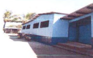
Foto 3: Pintura en muros exteriores.
