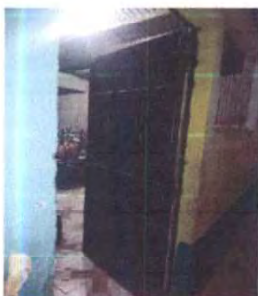
Foto 1: Mantenimiento y puesta de chapa .
