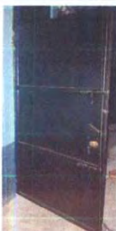
Foto 3: Mantenimiento y puesta de chapa .
