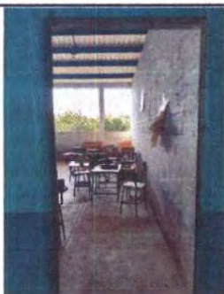
Foto 3: Mantenimiento y puesta de chapa .
