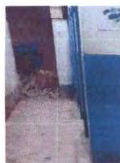
Foto 3: Mantenimiento de puertas baños.
