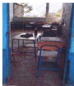
Foto 2: Cambio de puerta incluye chapa.
