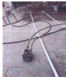
Foto 6: Sustrucción de bomba sumergible, tipo bala, cambio de tubería PVC y cableado de bomba de agua.
