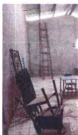
Foto 5: Mantenimiento y puesta de chapa .
