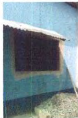
Foto 1: Ampliación de ventana incluye balcón.
