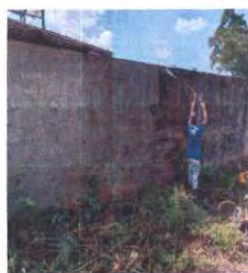
Foto 5: Pinturas en muros exteriores.
