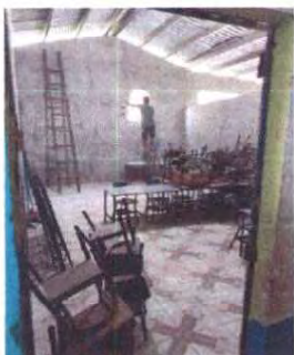
Foto1: Mantenimiento y puesta de chapa .
