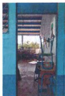
Foto 2: Mantenimiento y puesta de chapas.
