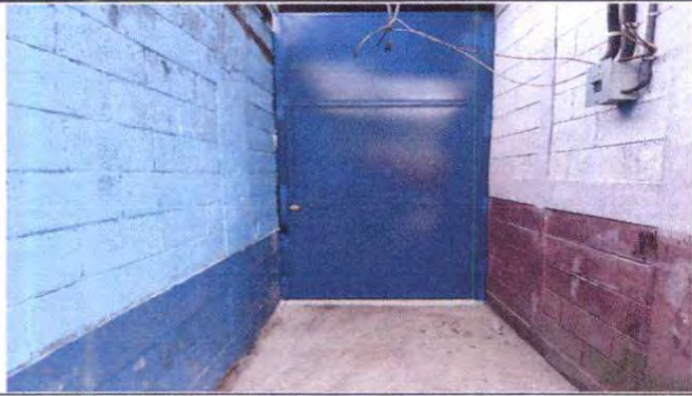
Foto 1: Sustrucción de puerta con chapa para cocina
