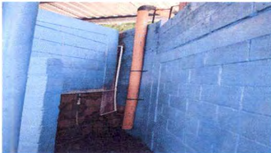
Foto 5: Suministro de de bajada de agua pluvial PVC 4" para salón de usos múltiples
