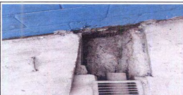
Foto 5: Mantenimiento a reposaderas
