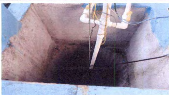
Foto 1: Sustrucción de bomba sumergible para abastecimiento de agua del pozo artesanal
