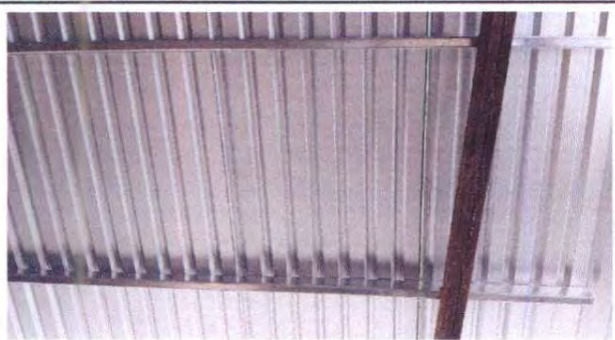
Foto 1: Cubierta de lámina acanalada por troquelada zintroalum, salón de usos múltiples
