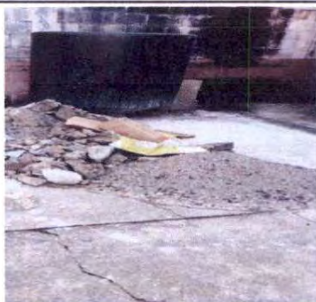
Foto 5: mantenimiento a reposadera
