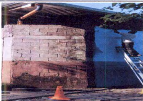
Foto 3: Suministro de canal de metal americano calibre 26 para salón de usos múltiples
