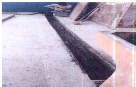
Foto 4: mantenimiento a reposadera
