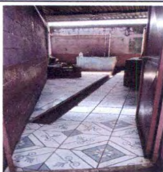
Foto1: Sustitución de puerta con chapa para cocina
