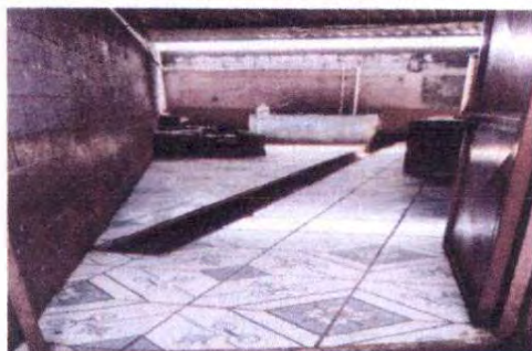
Foto 3: Sustitución de piso cerámico por piso cerámico antideslizante para la cocina
