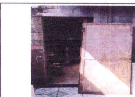
Foto 6: Sustitución e instalación de puertas con chapa para bodega de cocina
