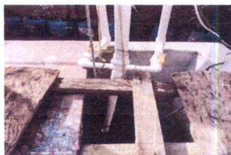
Foto 2: Sustrucción de bomba sumergible para abastecimiento de agua del pozo artesanal
