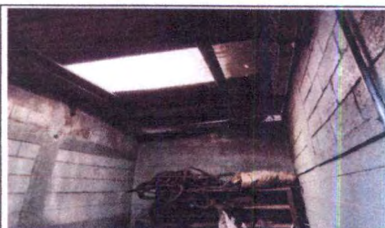
Foto 4: sustitución Estructura de soporte de metal por metal y techado de bodega de cocina
