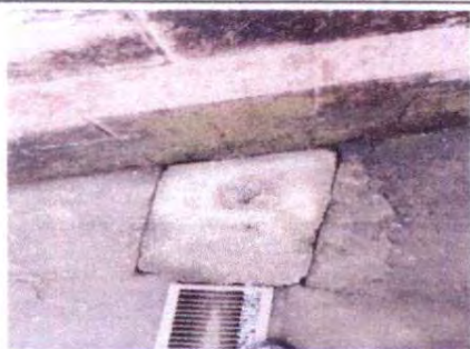
Foto 5: Mantenimiento a reposadera.
