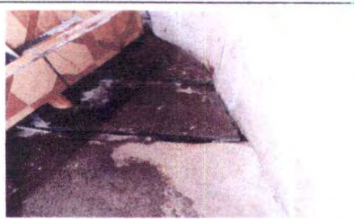
Foto 6: Mantenimiento a reposadera.
