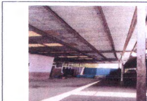
Foto 3: sustitución Estructura de soporte de metal por metal salón usos múltiples
