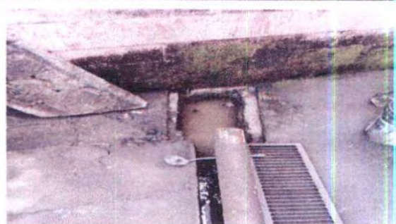
Foto 4: Mantenimiento a reposadera
