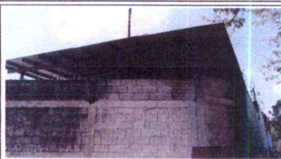
Foto 2: Cubierta de lámina acanalada por troquelada zintroalum, salón usos múltiples
