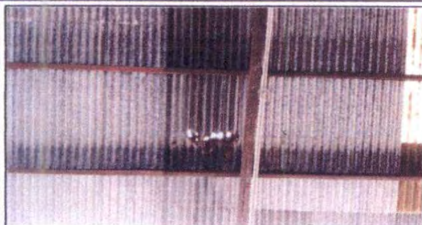
Foto 1: Cubierta de lámina acanalada por troquelada zintroalum, salón usos múltiples
