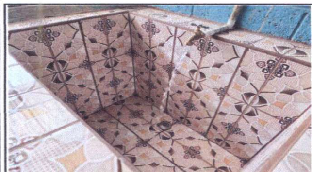
Foto 3: Suministro e instalación de sifon.
