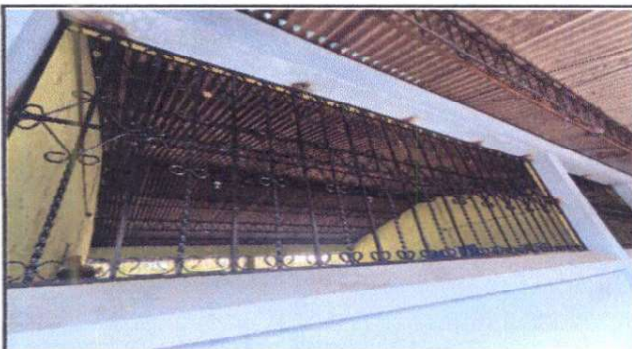
Foto 9: Mantenimiento a balcones
