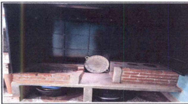
Foto 11: Reparación de área de cocina
