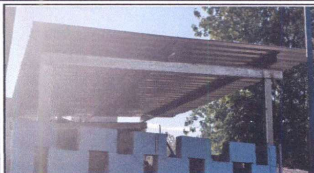
Foto 1: Sustrución y suministro de techado y estructura metalica de pila.
