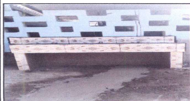
Foto 5: Suministro e instalación de 3 chorros para lavamanos.
