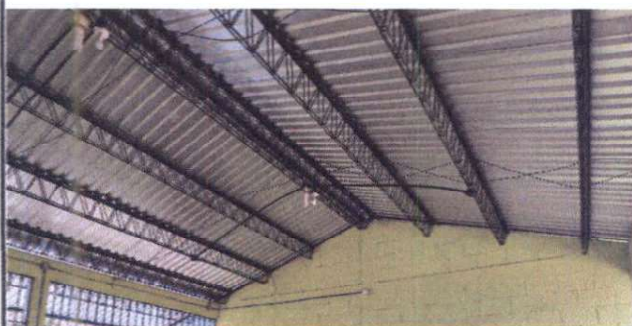
Foto 7: Sustitución de cubierta de lámina por lámina troquelada en aulas, suministro de costaneras como refuerzo de joyst existente, mantenimiento de estructura de joyst
