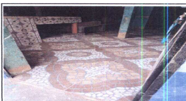
Foto 6: Suministro de piso de concreto por ceramico, en cocina. .
