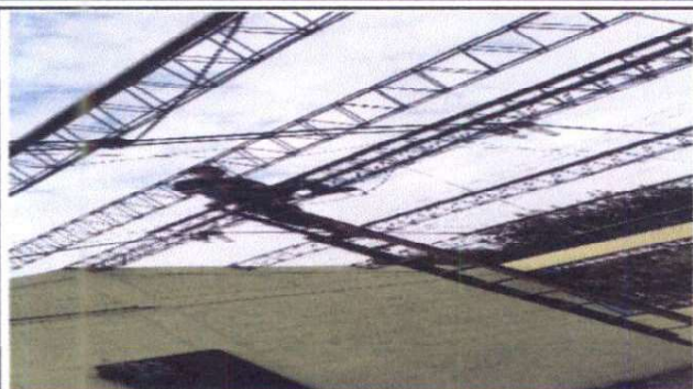
Foto 7: Sustrucción de cubierta de lámina por lámina troquelada en aulas, suministro de costaneras como refuerzo de joyst existente, mantenimiento de estructura de joyst
