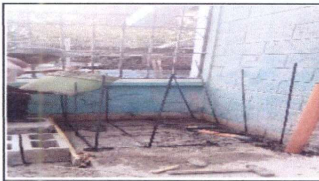
Foto 3: Suministro e instalación de sifon.
