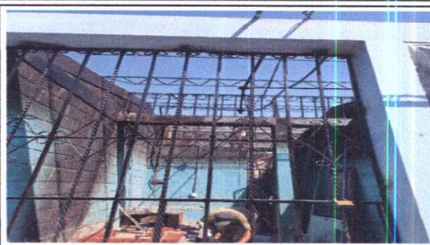
Foto 8: Sustrucción de cubierta de lámina por lámina troquelada en aulas, suministro de costaneras como refuerzo de joyst existente, mantenimiento de estructura de joyst
