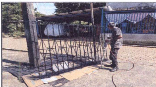
Foto 9: Mantenimiento a balcones
