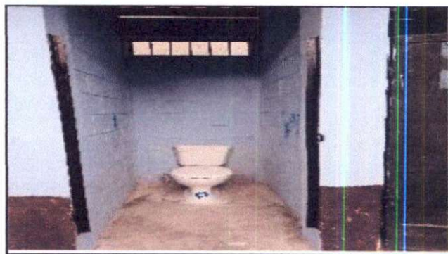
Foto 4: Reparación de 3 puertas de metal.
