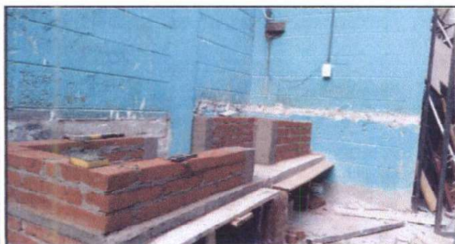
Foto 11: Reparación de área de cocina
