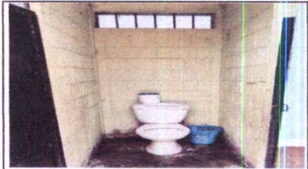
Foto 2: Sustitucion y suministro de 3 baños.
