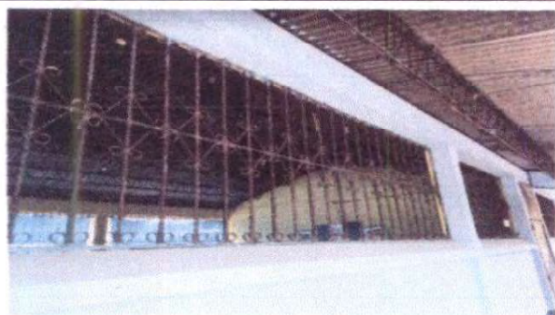
Foto 9: Mantenimiento a balcones
