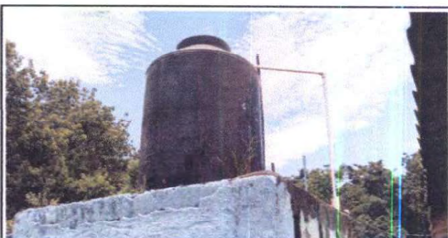
Foto 12: Sustitución de depósito de agua
