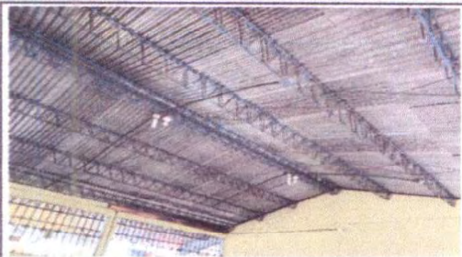
Foto 7: Sustitución de cubierta de lámina por lámina troquelada en aulas, suministro de costaneras como refuerzo de joyst existente, mantenimiento de estructura de joyst
