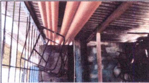
Foto 1: Sustitucion y suministro de techado y estructura metalica de pila.
