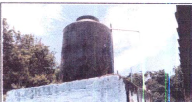
Foto 12: Sustitución de depósito de agua
