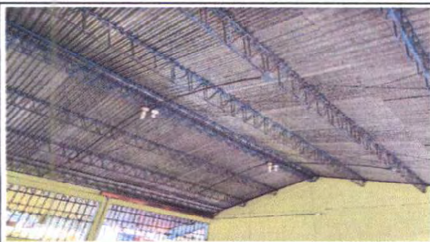
Foto 7: Sustitución de cubierta de lámina por lámina troquelada en aulas, suministro de costaneras como refuerzo de joyst existente, mantenimiento de estructura de joyst
