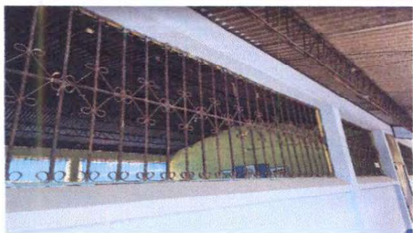
Foto 9: Mantenimiento a balcones
