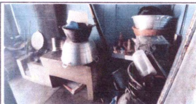
Foto 11: Reparación de área de cocina
