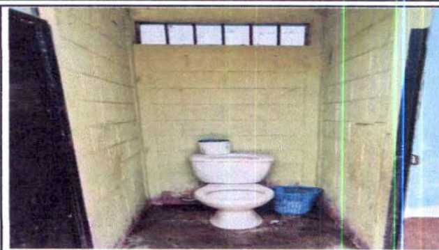
Foto 2: Sustitución y suministro de 3 baños.
