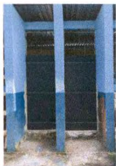
Foto 17: Sustrucción baranda de metal
