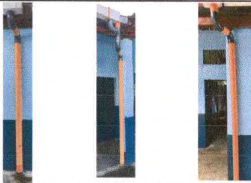
Foto 9: Sustrucción de bajada de agua pluvial tubo PVC 3".
