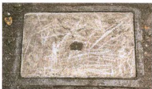
Foto 23: Sustitución caja de contador
