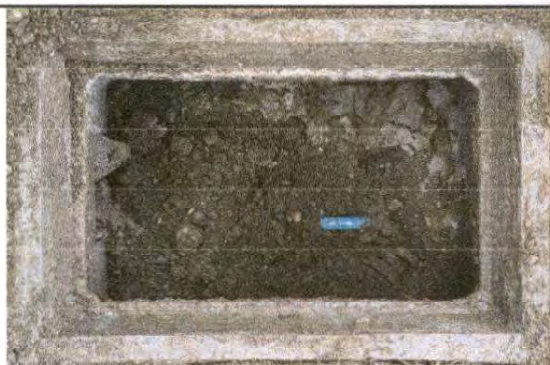
Foto 16: Sustrucción llave de paso
