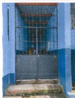
Foto 18: Mantenimiento de Portones
