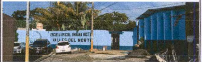
Foto 10: Pintura en muros exteriores
