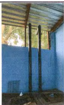
Foto 29: Sustrución chimenea de metal
