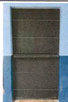
Foto 3: Mantenimiento a Puertas
