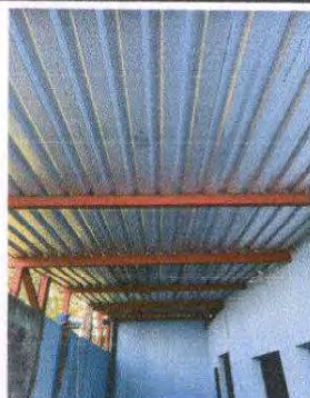
Foto 1: Cubierta de Lámina
