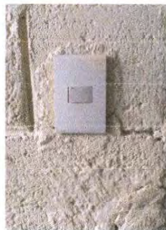
Foto 26: Sustrución interruptores dobles
