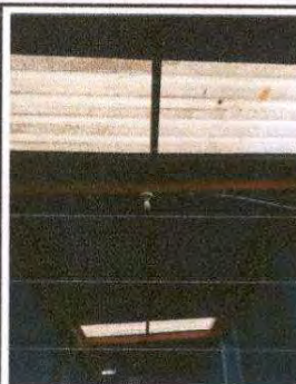
Foto 2: Estructuras de techo
