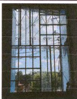
Foto 5: Sustitución de vidrios.
