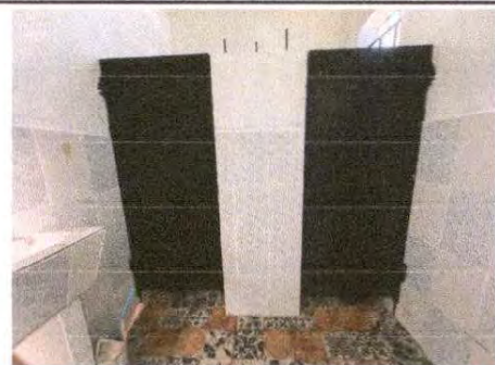
Foto 12: Mantenimiento a puertas de servicios sanitarios.
