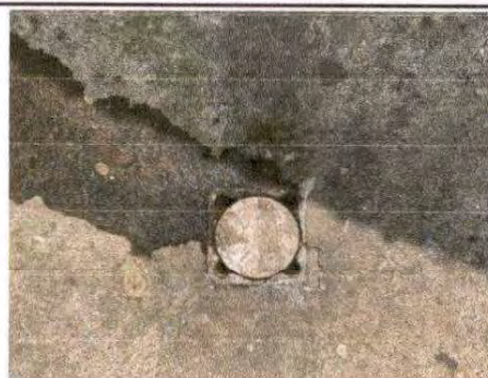
Foto 20: Sustitución de reposadera
