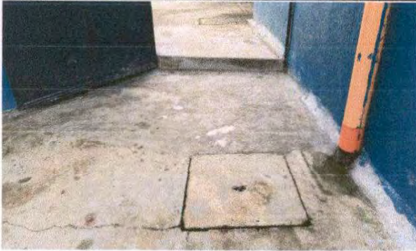
Foto 7: Sustrucción torta de concreto.
