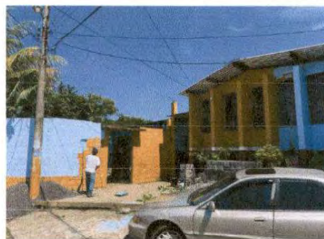
Foto 10: Pintura en muros exteriores
