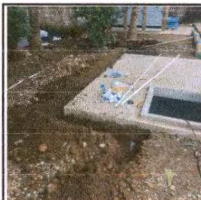
Foto 22: Sustitución tubería principal
