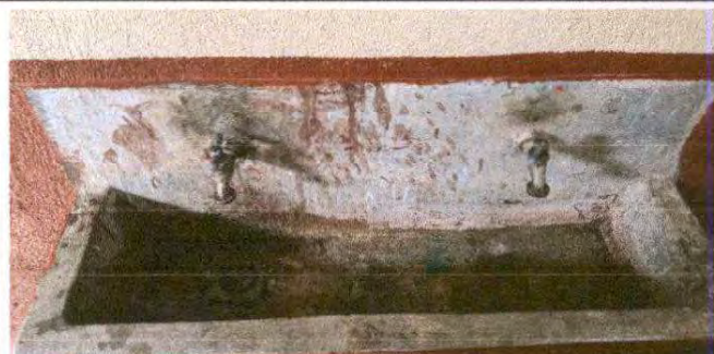
Foto 24: Sustitución de llave de chorros
