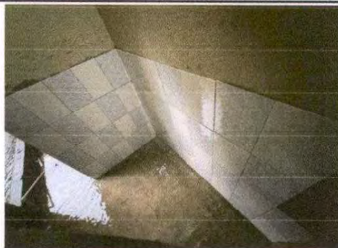
Foto 19: Reparación o sustitución de azulejo
