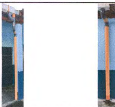
Foto 9: Sustitución de bajada de agua pluvial tubo PVC 3".
