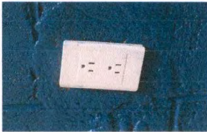
Foto 27: Sustitución tomacorriente dobles
