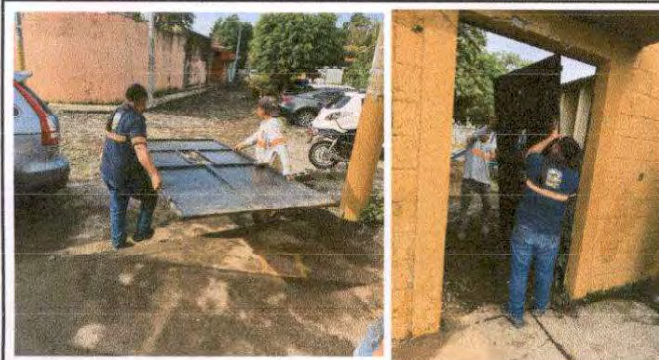
Foto 3: Mantenimiento a Puertas
