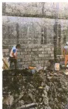
Foto 15: Reparación de muro perimetral de block con tubo hg y malla galvanizada, soleras intermedias y columnas.
