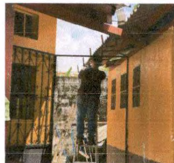
Foto 8: Sustitución de canal de PVC.
