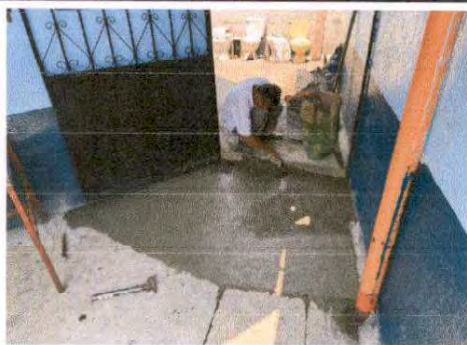
Foto 7: Sustitución torta de concreto.
