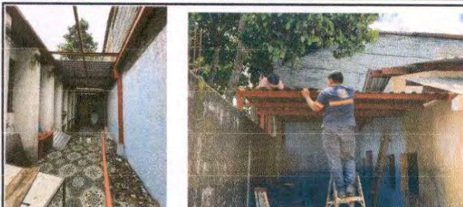
Foto 1: Cubierta de Lámina
