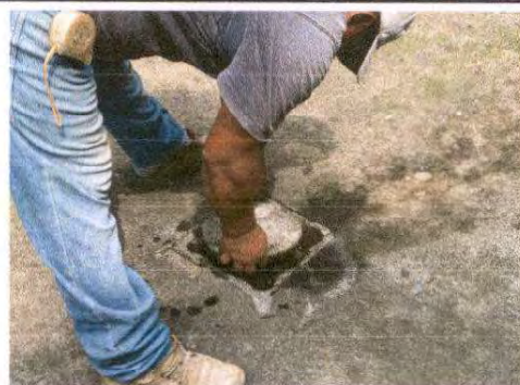
Foto 20: Sustitución de reposadera
