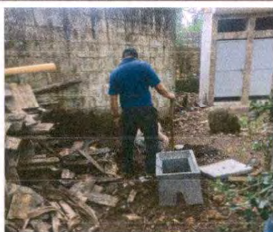
Foto 23: Sustitución caja de contador
