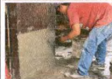
Foto 30: Repello y cernido en muro
