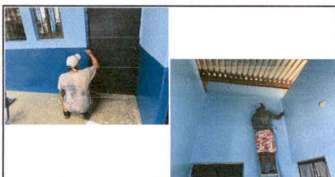
Foto 11: Pintura en muros interiores
