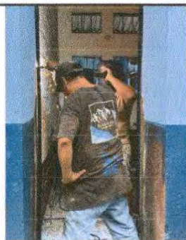
Foto 17: Sustrucción baranda de metal
