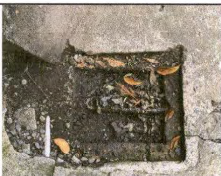
Foto 23: Sustitución caja de contador
