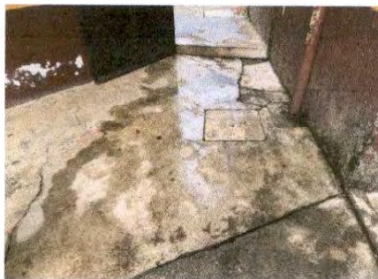
Foto 7: Sustrucción torta de concreto.
