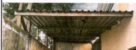
Foto 2: Estructuras de techo
