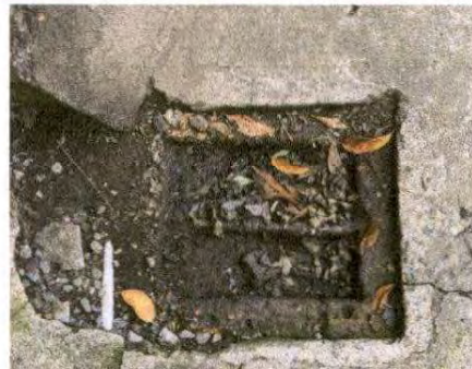
Foto 16: Sustitución llave de paso
