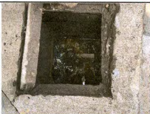
Foto 21: Sustitución caja de registro
