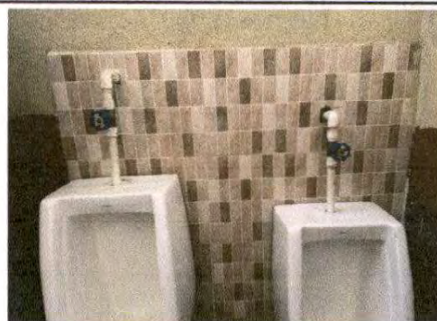
Foto 14: Sustitución llave en mingitorio
