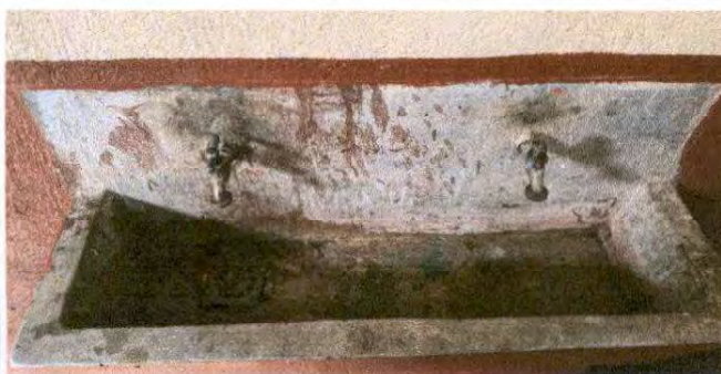
Foto 15: Sustitución de grifos
