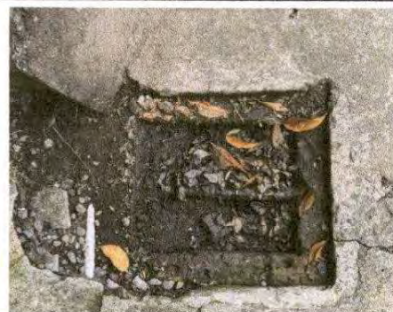
Foto 22: Sustitución tubería principal
