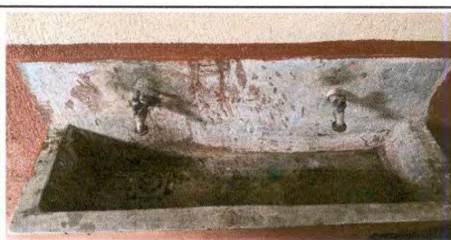
Foto 24: Sustitución de llave de chorros
