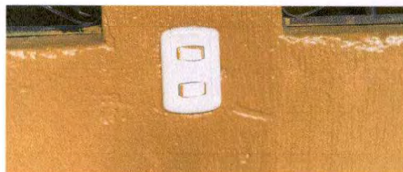
Foto 26: Sustitución interruptores dobles
