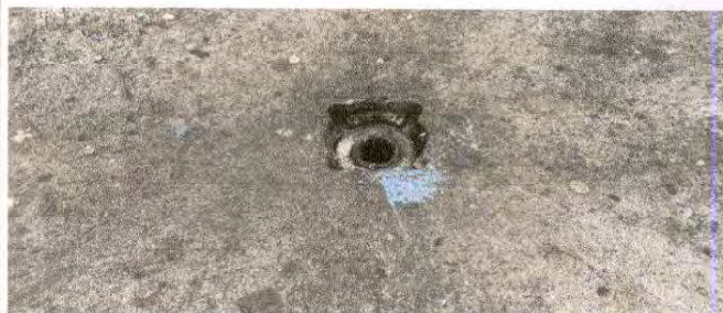
Foto 20: Sustitución de reposadera
