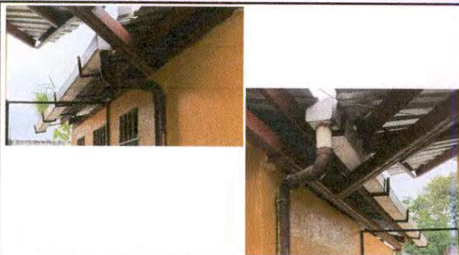
Foto 8: Sustrucción de canal de PVC.
