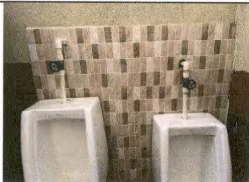
Foto 19: Reparación o sustitución de azulejo
