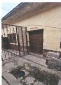
Foto 5: Sustrucción de puerta de bodega
