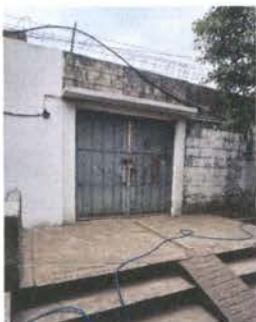
Foto 7: Sustrucción de portón secundario del establecimiento
