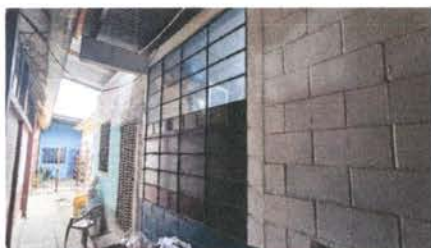
Foto 3: Colocación de balcón en ventana de la dirección
