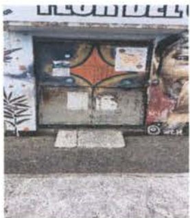
Foto 1: Sustrucción de portón principal
