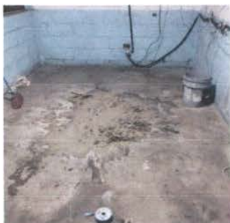
Foto 9: Sustrucción de piso de concreto por piso cerámico en dirección
