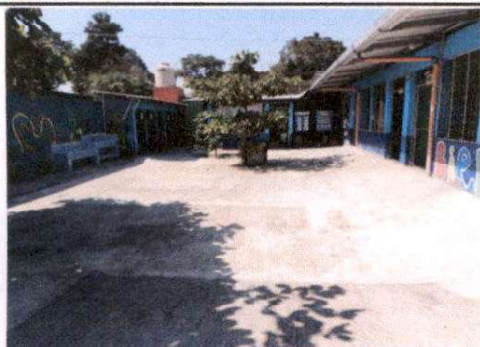
Foto 1: Sustrucción de losa de patio de concreto
