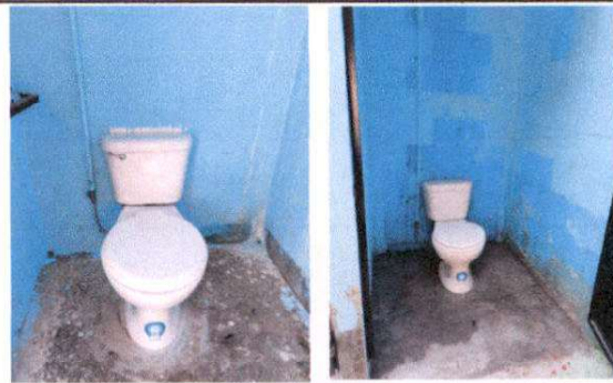
Foto 4: Suministro de dos inodoros infantiles en servicios sanitarios, suministro de puerta de meta, suministro de tubería para abastecimiento de agua y aplicación de pintura en muros.
