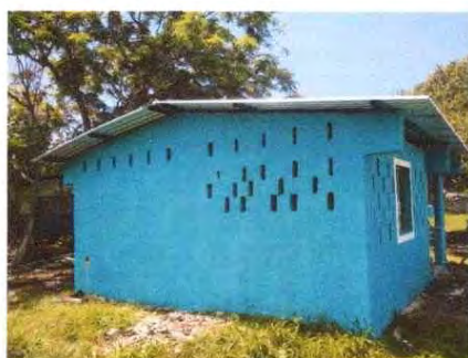
Foto 11: Repello y pintura exterior e interior
