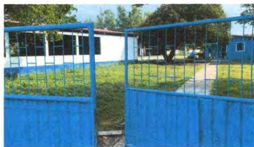
Foto 5: Mantenimiento de portón
