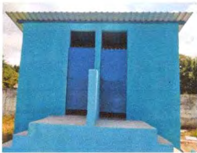
Foto 11: Sustrución de puerta
