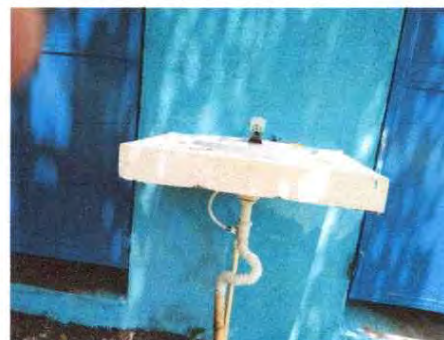
Foto 6: Instalación de lavamanos
