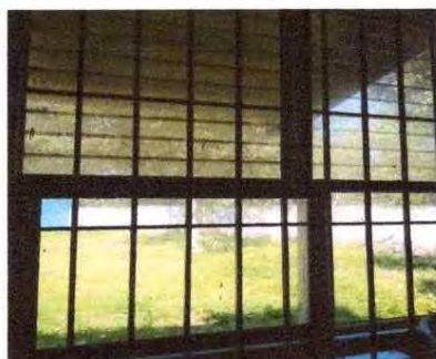
Foto 1: Instalación de balcones
