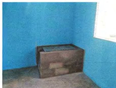
Foto 8: Sustitución de estufa rural completa
