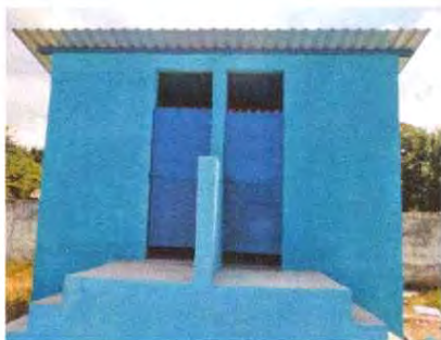
Foto 3: Sustitución e instalación de puertas
