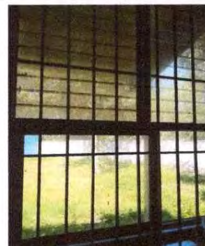
Foto 2: Instalación de balcones
