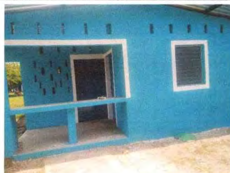
Foto 10: Instalación de ventana de metal
