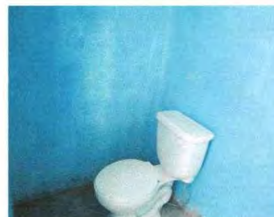
Foto 4: Sustitución de sanitarios
