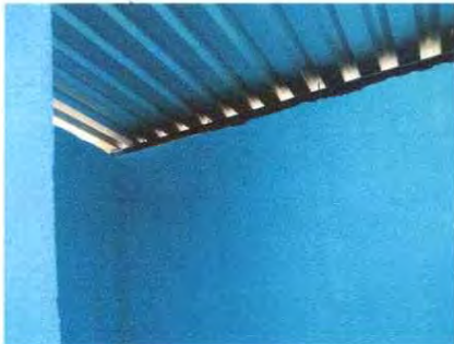
Foto 9: Sustrución de láminas
