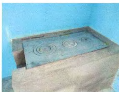
Foto 12: sustitución de estufa rural y plancha de metal
