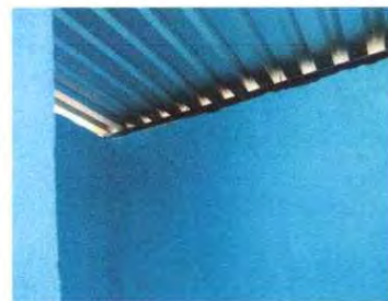
Foto 2: Repello exterior e interior
