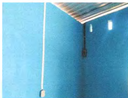
Foto 9: Sustitución de tomacorriente más iluminación
