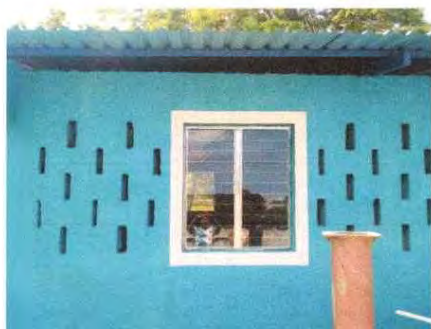
Foto 7: Sustitución de ventana de madera por metal
