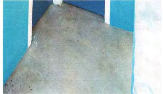
Foto 8: Sustrución de piso
