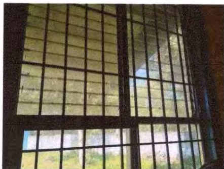
Foto 1: Instalación de balcones
