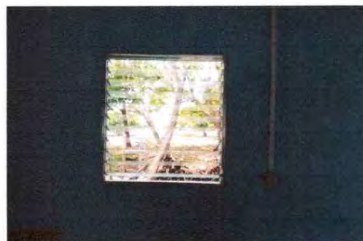
Foto 10: Instalación de ventana de metal
