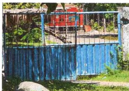
Foto 5: Mantenimiento de portón
