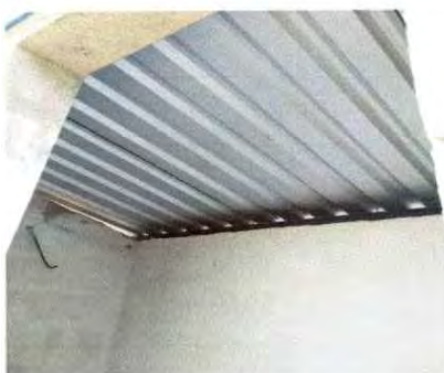
Foto 9: Sustrución de láminas
