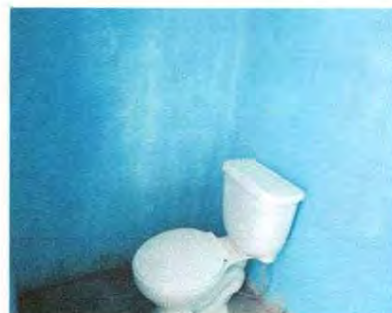
Foto 4: Sustitución de sanitarios
