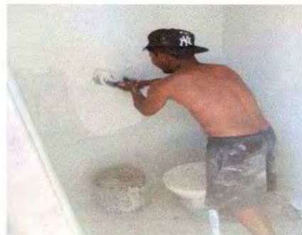
Foto 2: Repello exterior e interior
