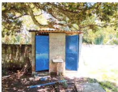
Foto 3: Sustitución e instalación de puertas
