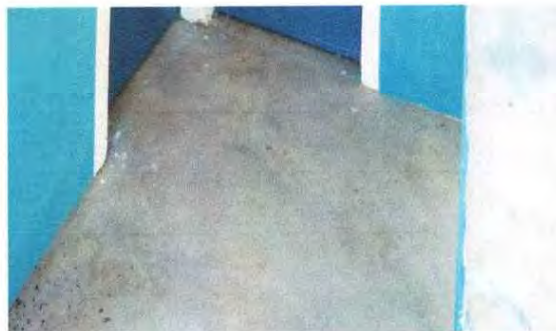
Foto 8: Sustrución de piso
