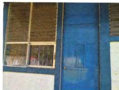
Foto 4: Sustitución de puerta de madera por puerta de metal
