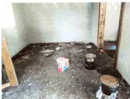
Foto 7: Sustrución de piso
