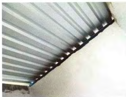
Foto 10: Sustrución de lámina
