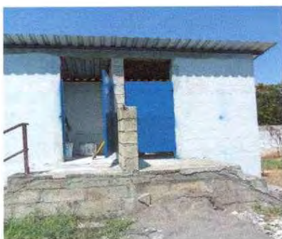
Foto 11: Sustrución de puerta
