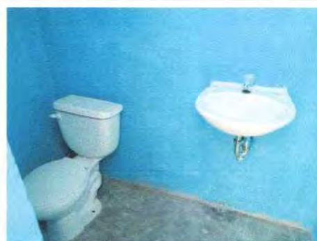
Foto 6: Instalación de lavamanos
