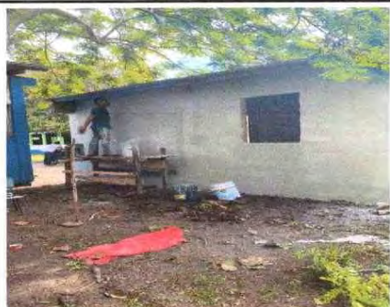
Foto 11: Repello y pintura exterior e interior
