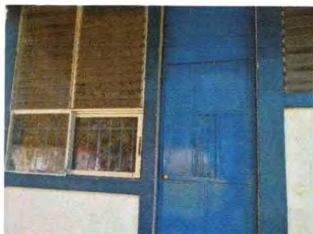
Foto 3: Sustitución de puerta de madera por puerta de metal
