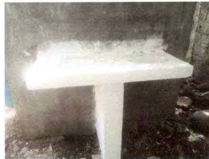
Foto 12: Sustrución de lavamanos
