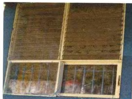
Foto 2: Instalación de balcones
