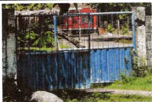
Foto 5: Mantenimiento de portón
