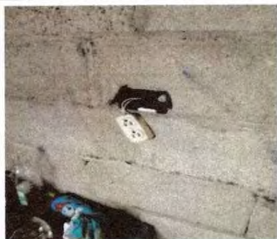
Foto 9: Sustitución de tomacorriente más iluminación
