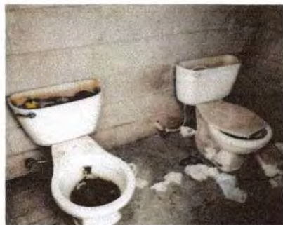
Foto 4: Sustitución de sanitarios
