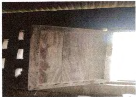
Foto 7: Sustitución de ventana de madera por metal
