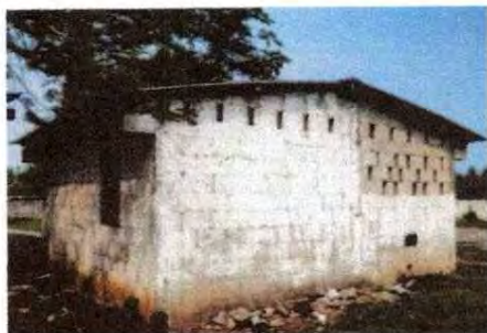
Foto 11: Repello y pintura exterior e interior
