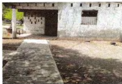
Foto 10: Instalación de ventana de metal
