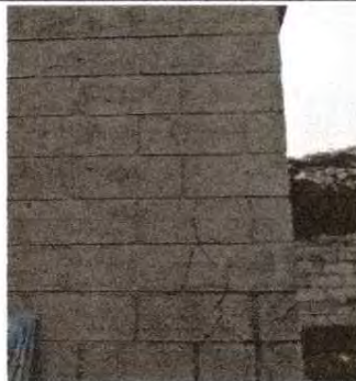
Foto 2: Repello exterior e interior
