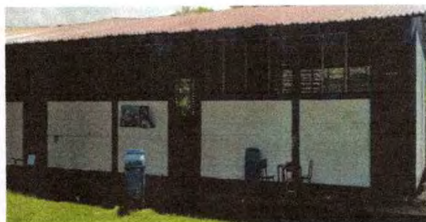
Foto 2: Instalación de balcones
