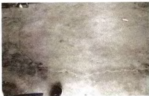
Foto 1: Sustrucción de piso de torta de concreto
