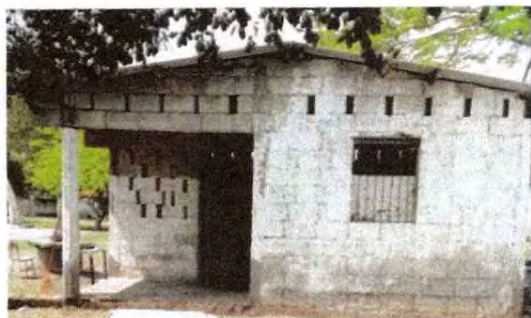
Foto 3: Pintura interior y exterior
