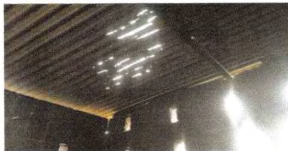
Foto 6: Sustrucción de láminas
