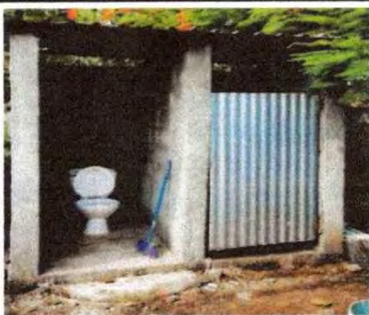
Foto 3: Sustitución e instalación de puertas
