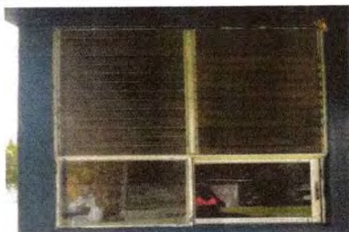
Foto 1: Instalación de balcones
