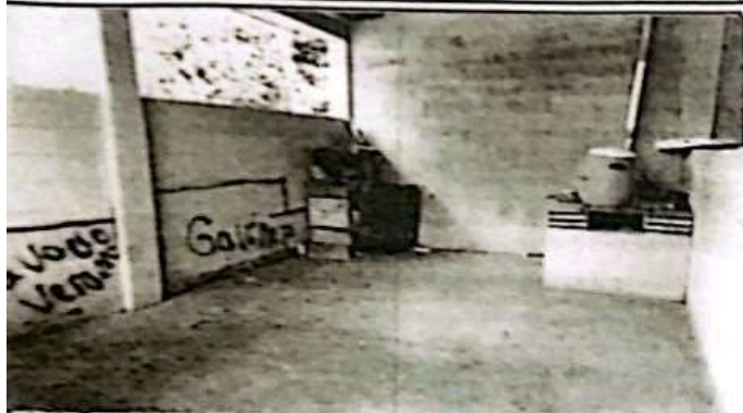
Foto 1: Suministro de mesa de concreto revestida de azulejo, mantenimiento de estufa rural, sustitución de pila, sustitución de piso de concreto por piso cerámico
