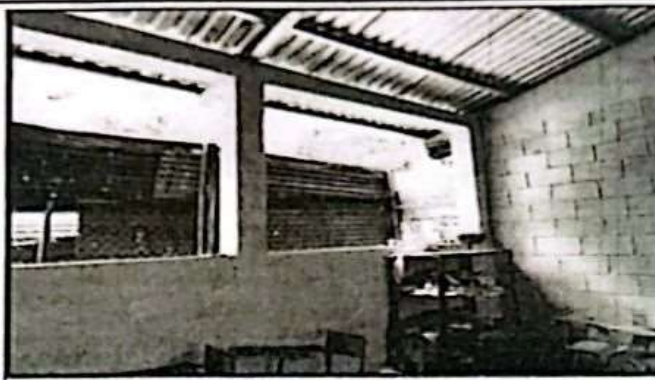
Foto 2: Suministro de ventanas y balcones de estructura metálica
