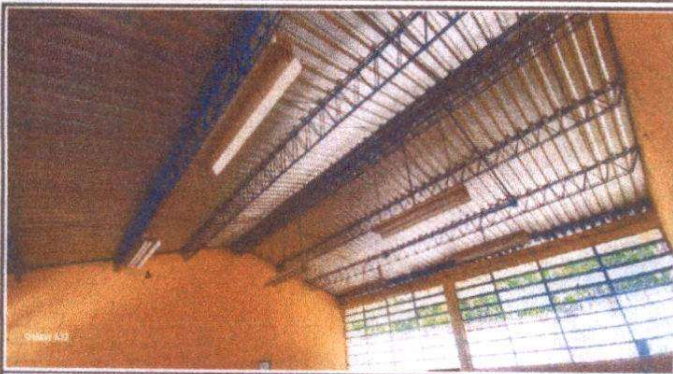
Foto 1. Reparación de sistema eléctrico en aulas.
