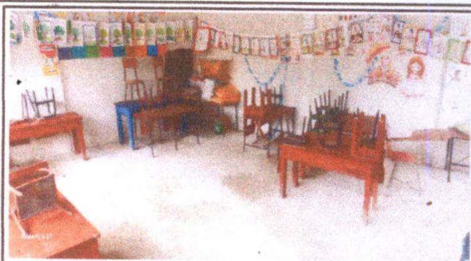
Foto. Sustitución de piso líquido por piso cerámico en aula.
