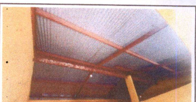
Foto 6. Sustitución de cubierta de lámina y estructura de soporte en aulas.
