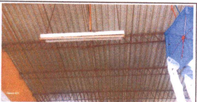
Foto 5. Reparación de sistema eléctrico en aulas.
