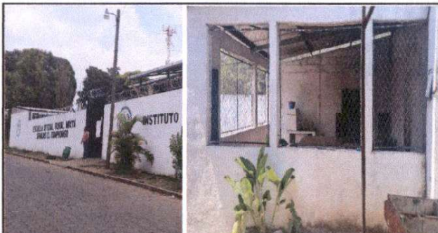
Pintura interior y exterior en muro perimetral del frente, Pintura en área de cocina.
