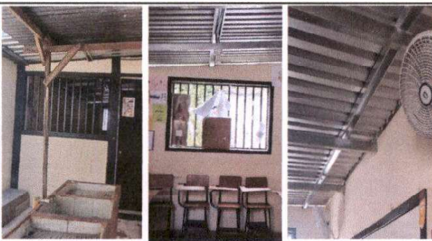
Instalación de ventana de aluminio mill finish y Reparación en unión de lámina con muro de concreto.
