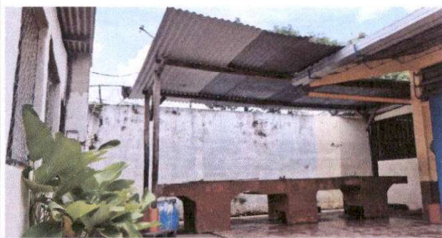
Sustitución de lámina, por lámina troquelada aluzinc calibre 26, sustitución de estructura de soporte de madera por metal, (mano de obra incluida)
