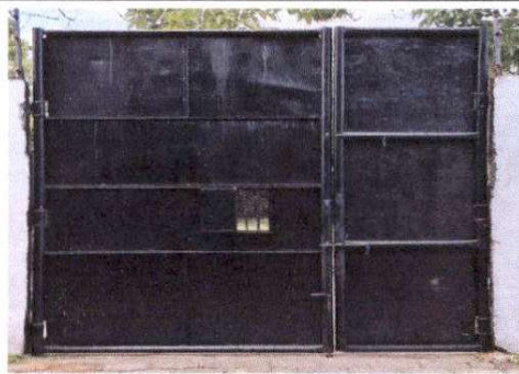
Mantenimiento a portones de metal
