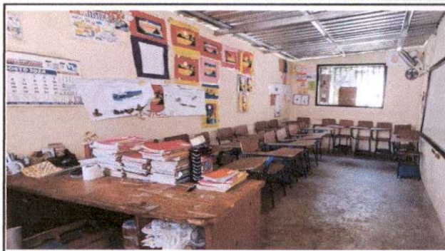
Instalación de piso cerámico antideslizante
