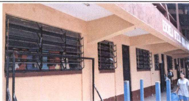
Mantenimiento a ventanas
