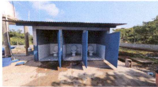
Aplicación de cernido en paredes interiores
