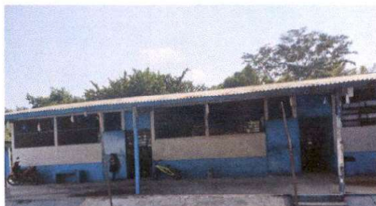
sustitución de ventanas por balcones
