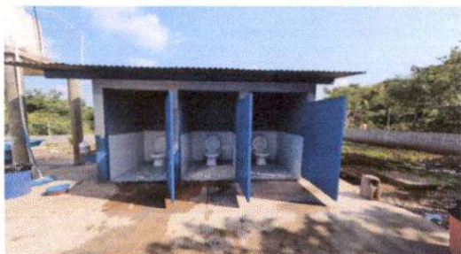
Suministro de azulejo en en muro de h: 1.00 metro.
