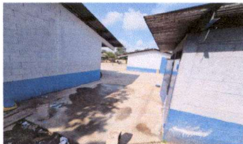
Sustitución de piso por losa de concreto en patio.
