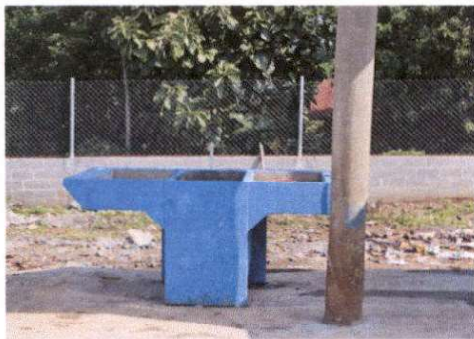
Suministro de pila con faldón corrido (incluye el suministro de tubería y accesorios para drenaje y abastecimiento de agua).
