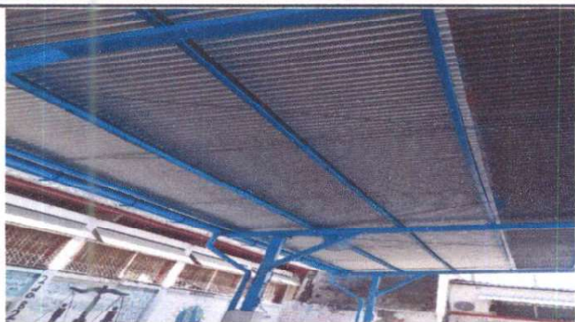
LÁMINA ALUZINC CALIBRE 26 INSTALADA
