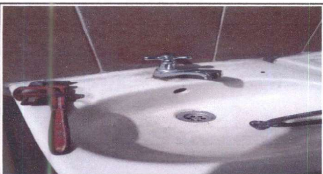
MEZCLADORA INSTALADA DE LAVAMANOS, CONTRALLAVE Y TUBO DE ABASTO
