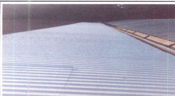
MANTENIMIENTO REALIZADO DE CUBIERTA DE LÁMINA CON APLICACIÓN DE IMPERMEABILIZANTE.
