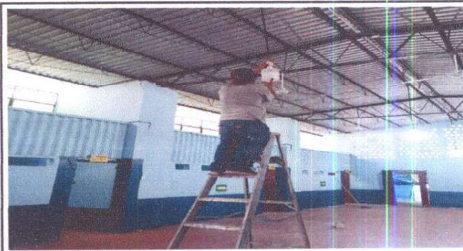
INSTALACIÓN DE FOCOS AHORRADORES.
