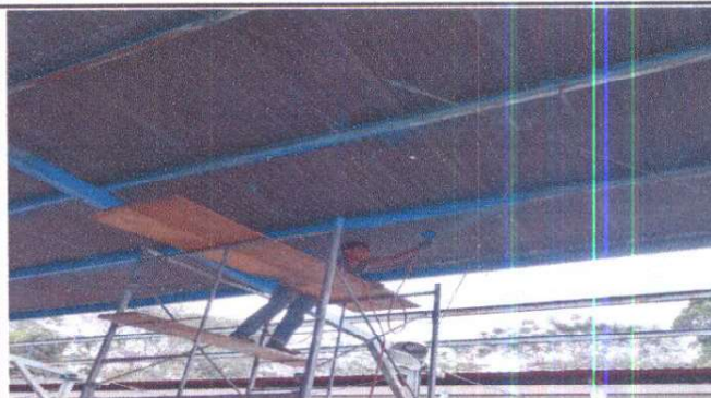
MANTENIMIENTO A ESTRUCTURA DE TECHO DE METAL (pintura)
