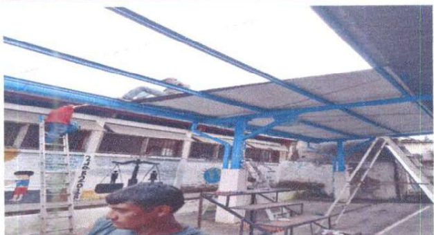
INSTALACIÓN DE LÁMINA POR LÁMINA ALUZINC CALIBRE 26.
