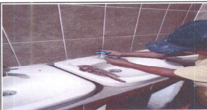
SUSTITUCIÓN DE MEZCLADORA DE LAVAMANOS, CONTRALLAVE Y TUBO DE ABASTO
