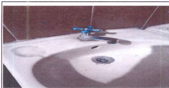
SUSTITUCIÓN MEZCLADORA DE LAVAMANOS, CONTRALLAVE Y TUBO DE ABASTO
