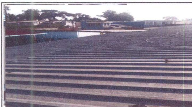
MANTENIMIENTO DE CUBIERTA DE LÁMINA CON APLICACIÓN DE IMPERMEABILIZANTE.
