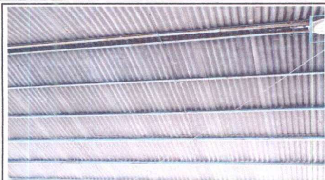
SUSTITUCIÓN DE LÁMINA POR LÁMINA ALUZINC CALIBRE 26.
